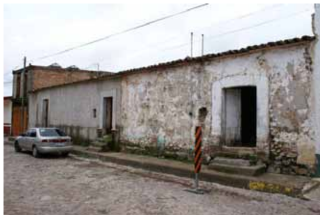
Construcción primera etapa Casa de Cultura en San Marcos
