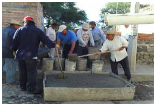
Instalación de piso firme.
