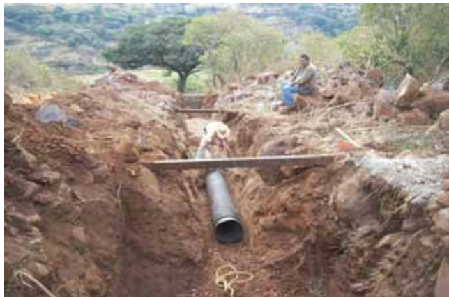
Construcción de Colectores en Tepatitlán
