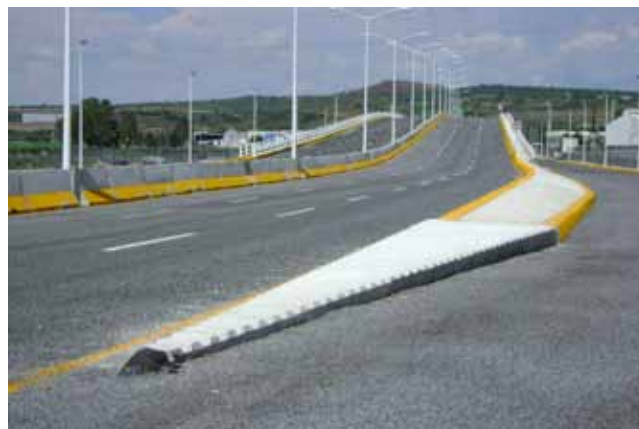
Paso Elevado Ferrocarril
