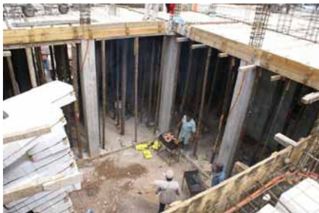
Construcción primera etapa casa de la cultura Huejuquilla el Alto
