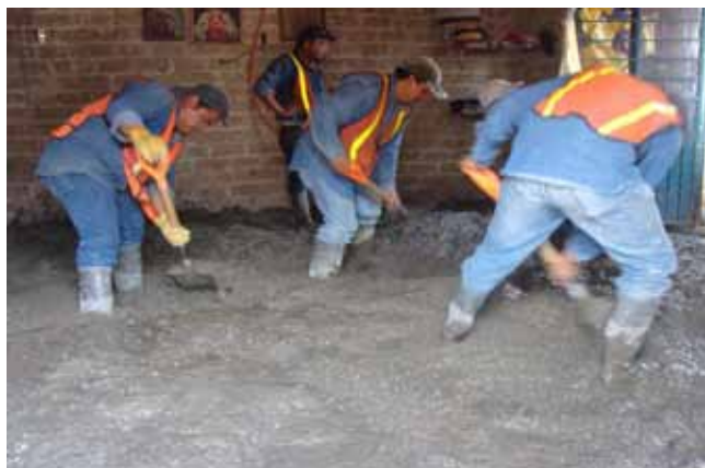
Instalación de piso firme.
