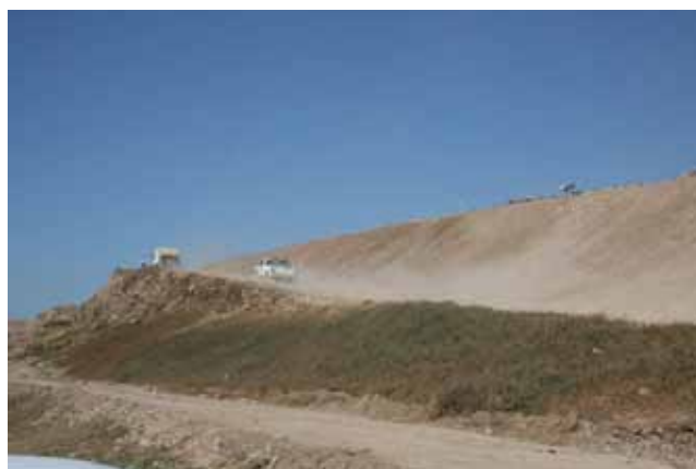
Construcción de relleno
