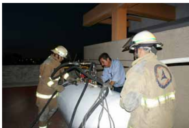
Supervisión de maniobras para trasvase de Gas L.p.
