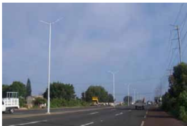
Ampliación 6 carriles, calle Ahualulco de Mercado-Ingreso a Coyula
