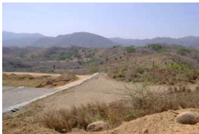
Celda de relleno Puerto Vallarta
