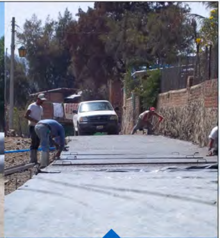
PAVIMENTACIÓN DE CALLES SAN JOSÉ DEL VALLE $616,296.80
