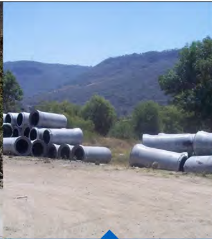
ENTUBADO DE AGUAS NEGRAS FRACC. SAN JAVIER $621,958.67
