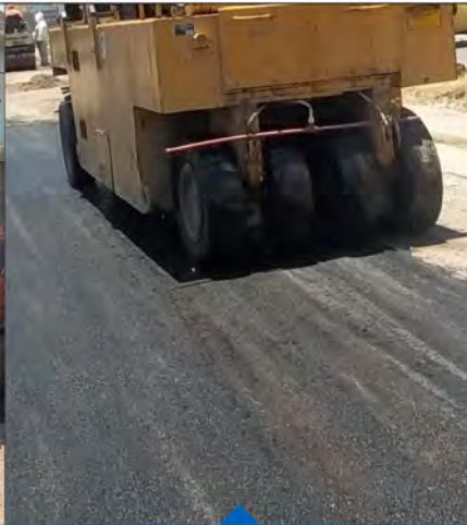
PAVIMENTACIÓN Y/O ASFALTADO EN EL VERGEL $68,264.67
