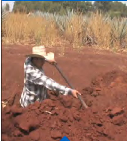
DRENAJE EN LA JOYA, OJO DE AGUA DE MORÁN $87,417.72
