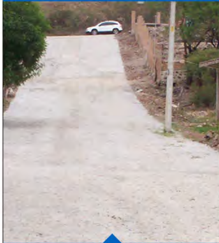
2DA. ETAPA EMPEDRADO ZAMPEADO EN LA PAREJA $573,444.87
