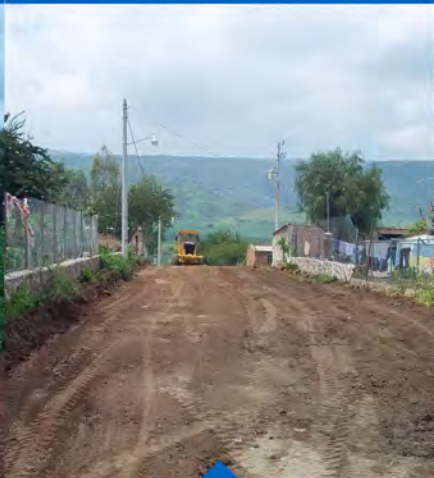
ARREGLO DE CALLES EN NUEVO VALLE $46,515.48
