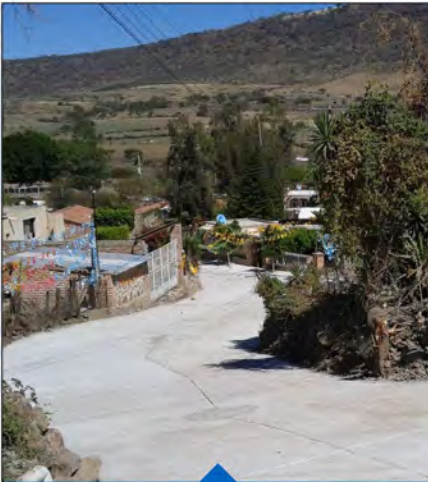
PAVIMENTACIÓN DE CALLES LA CONCEPCIÓN $316,377.20
