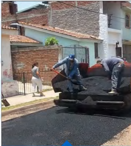
ASFALTADO Y BACHEO INFONAVIT MILPILLAS $332,336.64
