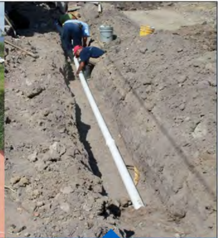
REHABILITACIÓN RED DE AGUA POTABLE MARGARITAS 2DA ETAPA $554,345.54
