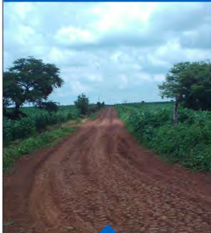
EMPEDRADO DE CAMINO AL PANALITO OJO DE AGUA DE MORÁN $61,062.40
