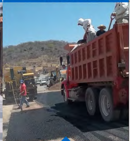
ASFALTADO Y BACHEO INGRESO A EL MAGUEY $265,597.10
