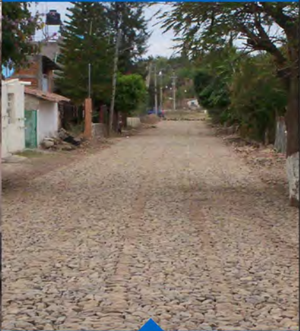
EMPEDRADO DE CALLES EN AGUA CALIENTE $372,878.94
