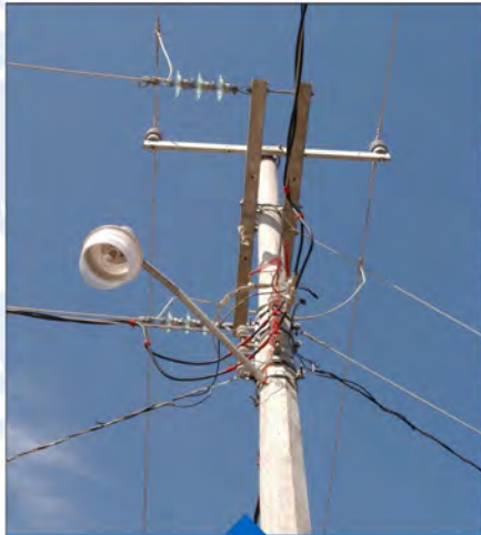
ELECTRIFICACIÓN SANTA QUITERÍA - SAN ÁNGEL $174,851.44
