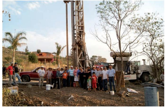
Perforación y equipamiento de pozo profundo de 110 metros, para abastecimiento de agua potable, con un diámetro de 8 1/2" pulgadas y construcción de tanque de regularización en la comunidad de Santa Rita. **INVERSIÓN \$476,716.51**
