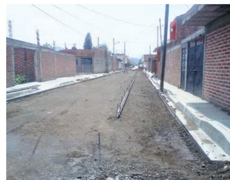
Construcción de banquetas de concreto hidráulico en las calles Jalisco y V. Carranza de La Ribera.
