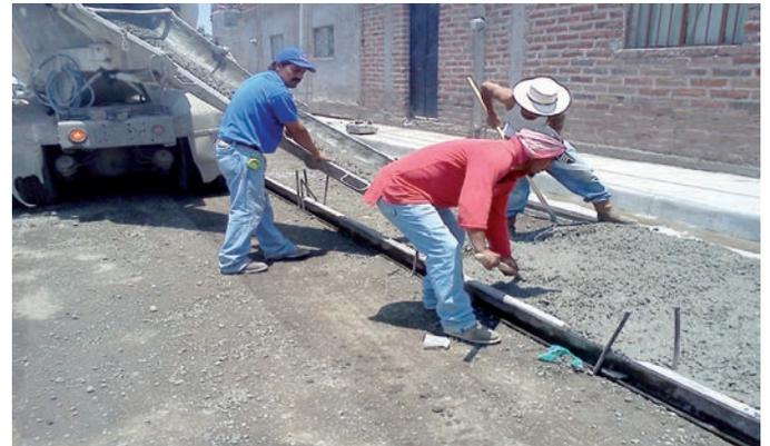
Pavimentación con concreto hidráulico en la calle Juárez de la comunidad de Mirandillas.
