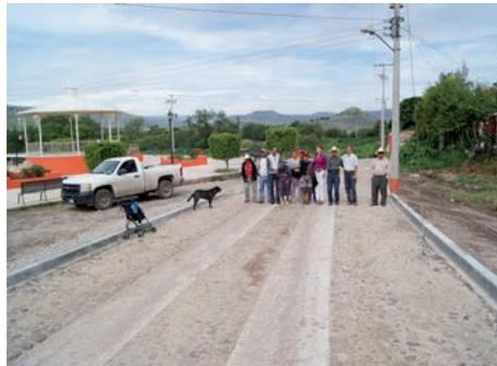
Construcción de empedrado ecológico y huellas de concreto en camino a Las Villas.
