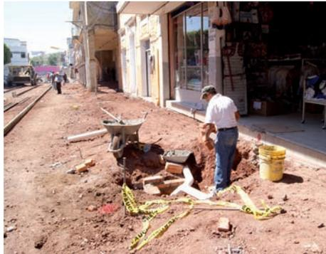
Introducción de la línea oculta de conducción eléctrica y canalización para líneas de teléfono y telecable en la calle Clemente Aguirre, en Ayotlán.
