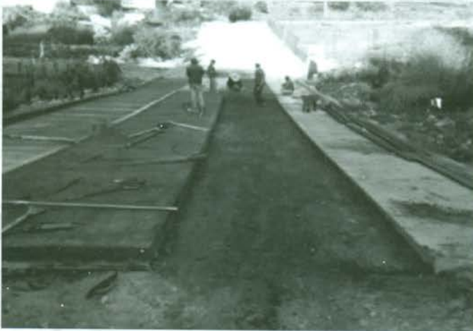
CONSTRUCCION DE PAVIMENTO EN ARROYO Y MACHUELO CON CONCRETO HIDRAULICO FC=200 KG/CM2 CALLE 1 DEMAYO
