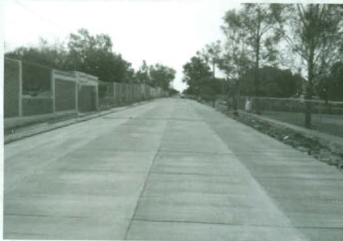
CONSTRUCCION DE PAVIMENTO EN ARROYO Y MACHUELO CON CONCRETO HIDRAULICO FC=200 KG/CM2 CALLE GABRIEL VELASQUEZ
