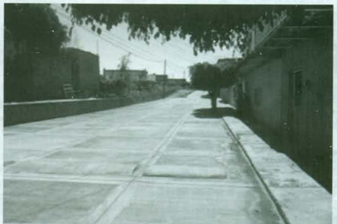
CONSTRUCCION DE PAVIMENTO EN ARROYO Y MACHUELO CON CONCRETO HIDRAULICO FC=200 KG/CM2 CALLE 5 DE MAYO ENTRE PLAN DE AYALA Y MANUEL M DIEGUEZ
