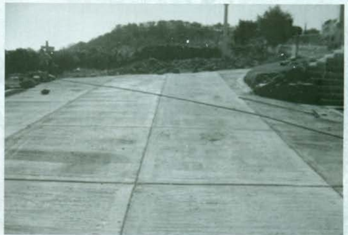
CONSTRUCCION DE RED DE AGUA POTABLE, DRENAJE Y PAVIMENTO EN ARROYO Y MACHUELO CON CONCRETO HIDRAULICO FC=200 KG/CM2 CALLE 5 DE MAYO ENTRE LIBERTAD Y MOISES QUEZADA.
