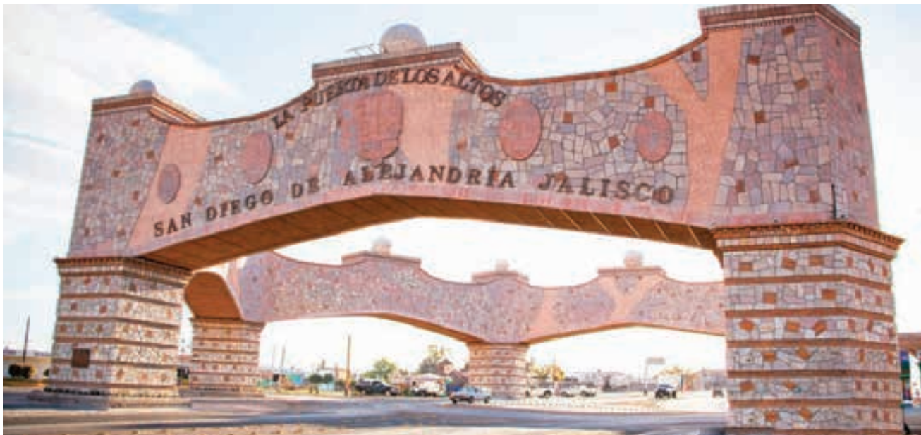
Rehabilitación de Cruceo Carretero de San Diego de Alejandría
