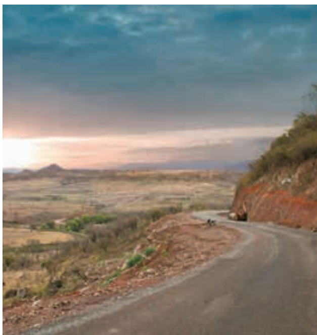
Atengo, Construcción de tramo carretero Soyatlán del Oro - Trigo de Alteñas
