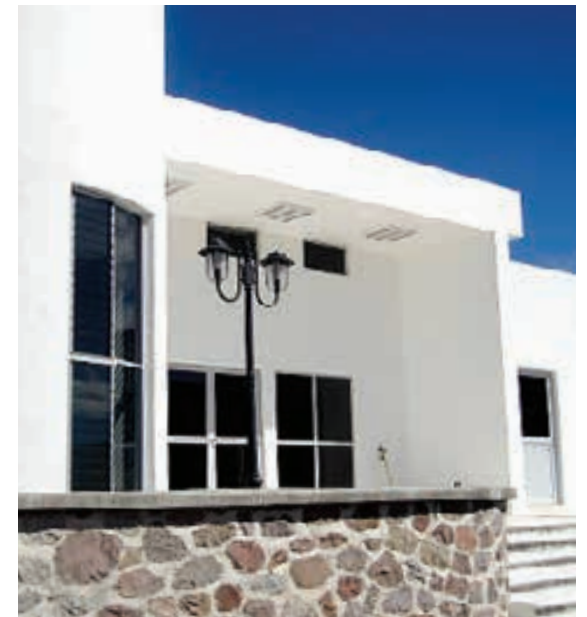
Construcción de Centro de Salud en Mezquicic
