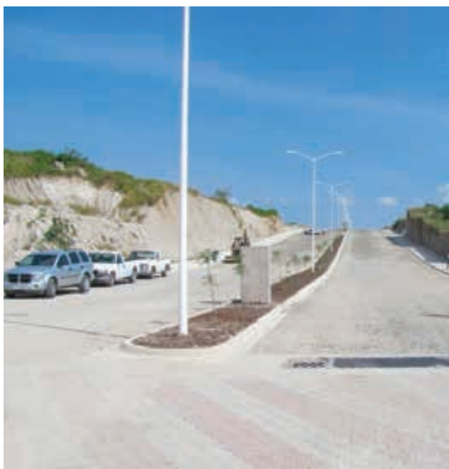
Construcción de nuevo ingreso a Tala
