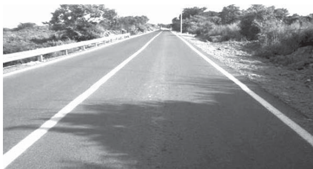
Tramo Amatitán-Santa Rosa
