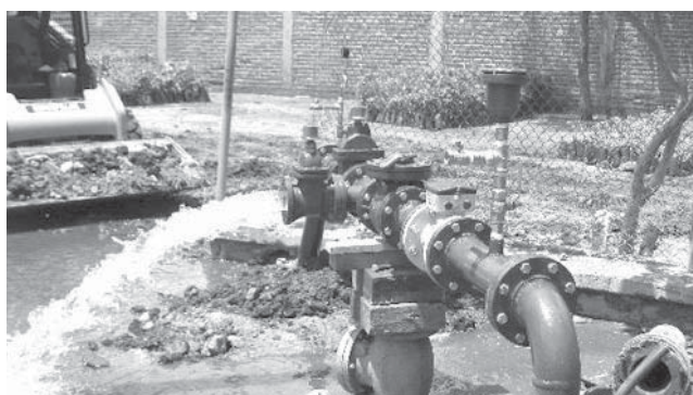
Obra de Abastecimiento en Ameca
