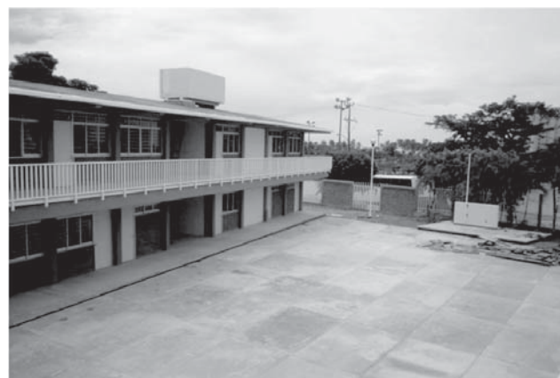
Puerto Vallarta, Col. 5 de diciembre, Primaria Club de Leones, 14EPR0438H Construcción de 8 aulas didácticas, núcleo de servicios sanitarios, dirección con anexo t/v, bodega, escalera, oficina de supervisión escolar y obra exterior.
