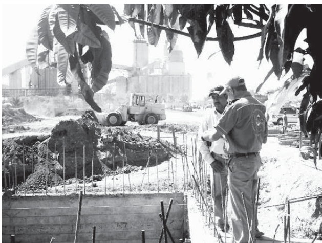
Inspección de medidas de seguridad en sitios de Riesgo.
