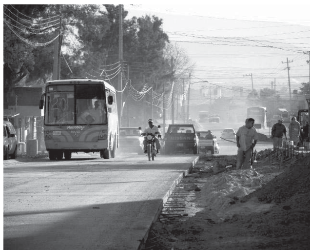
Colocación de concreto en la calle Gobernador Curiel
