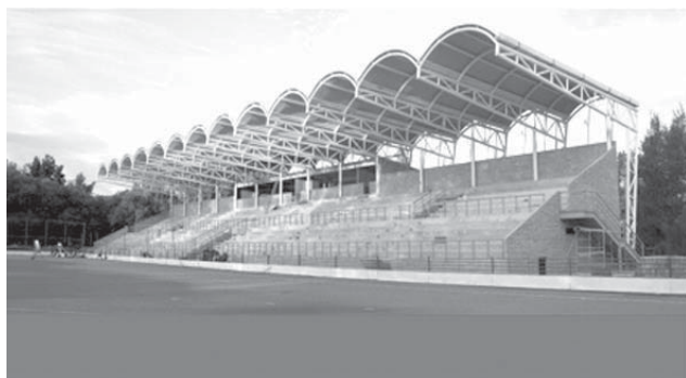
Avance de construcción
