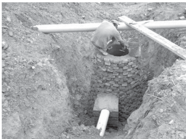
Construcción de pozo de visita
