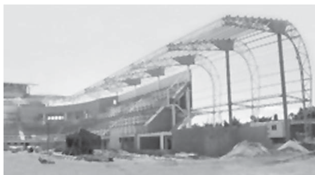
Avance de construcción
