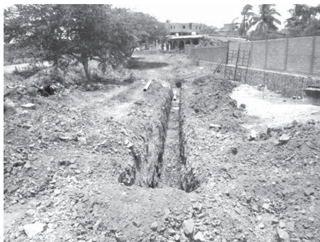
Instalación de tubería PVC
