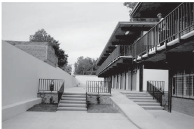
Tlaquepaque, San Martín de las Flores, Primaria Cuauhtémoc, 14DPR1089Z. Construcción de 12 aulas didácticas, 2 núcleos de servicios sanitarios, 2 direcciones con anexo, 2 bodegas, intendencia y escaleras, en sustitución del edificio atípico y obra exterior.
