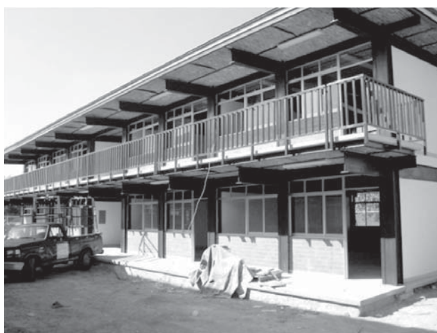
Tlaquepaque, Geovillas Los Olivos, Primaria Nueva Creación 14DPR65KPC Construcción de 13 aulas didácticas (una será utilizada como aula de medios), 2 direcciones con anexo, 2 bodegas, núcleo de servicios sanitarios, 2 escaleras, en sustitución de las aulas prefabricadas y obra exterior.
