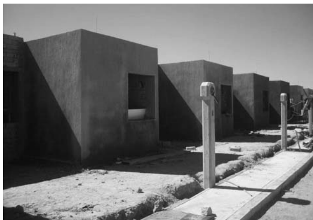
30 Viviendas en proceso de edificación en San Diego de Alejandría
