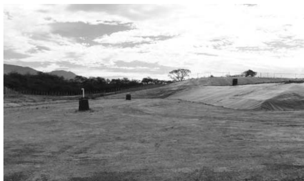
Construcción en Ameca
