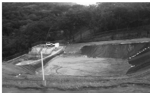
Construcción en Cabo Corrientes
