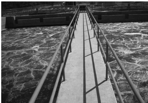
Planta de Tratamiento Ameca
