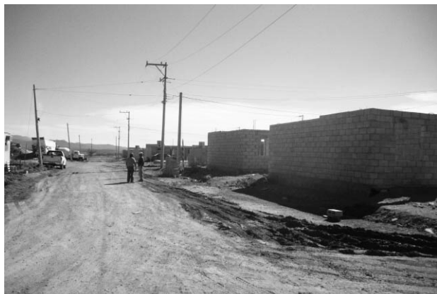
173 Viviendas en proceso de edificación en Tecolotlán
