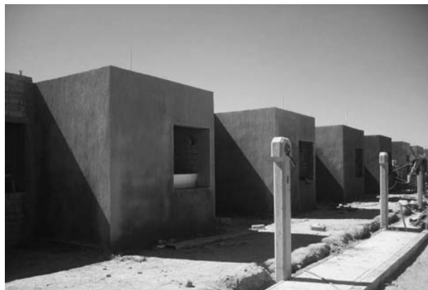
30 Viviendas en proceso de edificación en San Diego de Alejandría
