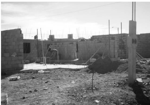
173 Viviendas en proceso de edificación en Tecolotlán
