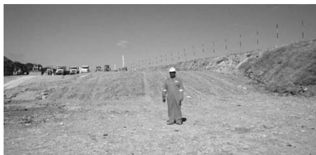
Relleno Sanitario GEN, Ixtlahuacán de los Membrillos
