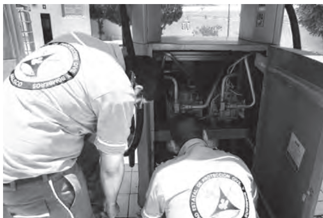
Inspectores verificando medidas de seguridad en instalaciones
