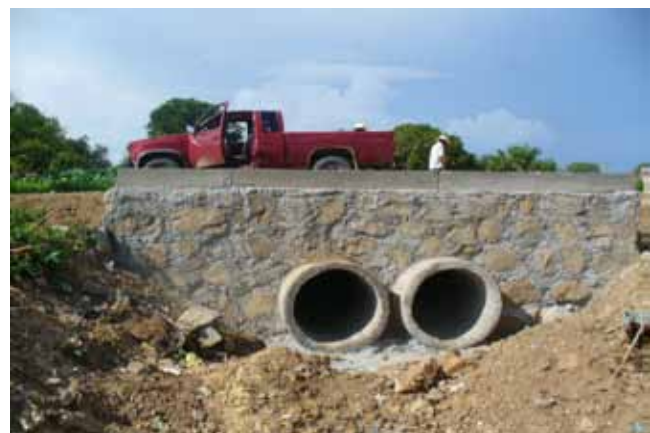
Obras de alcantarillado
