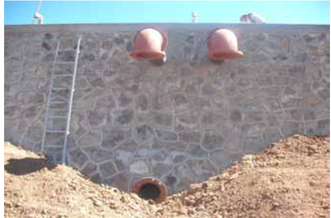
Construcción de Tanque de Almacenamiento en Ciudad Guzmán
