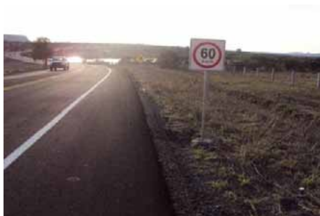
Terminación del Libramiento Sur Oeste Lagos de Moreno, tramo Kms 0+000 - 9+400
