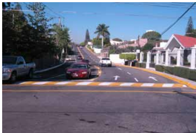
Modificación a la infraestructura vial
