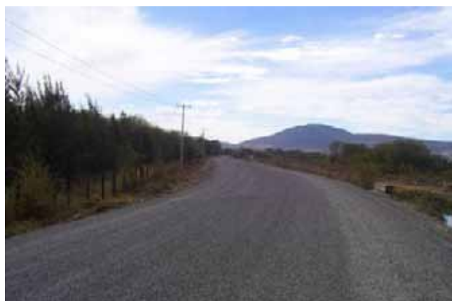
Pavimentación de 9.2 kms del tramo Juanacatlán-Miraflores
