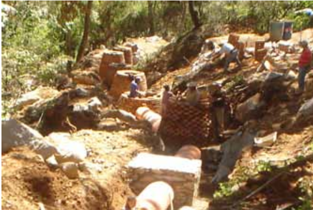
Fabricación de pozos y colocación de tubería
