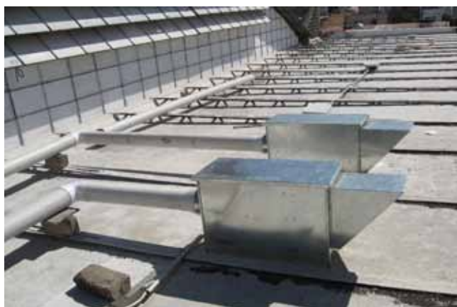
Instalación de equipos de control
