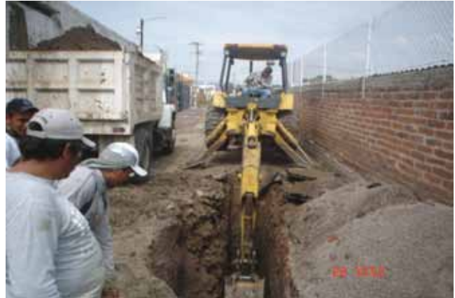
Instalación de tubería de 12 pulgadas
