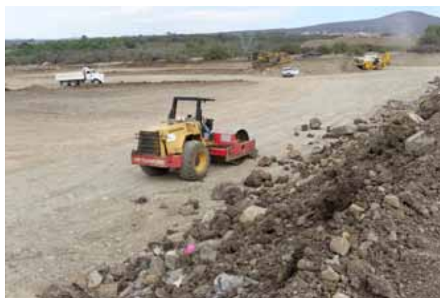
Construcción del Relleno Sanitario en Mazamitla
