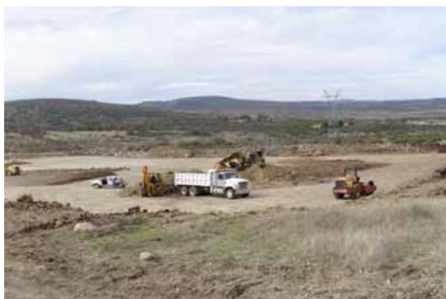
Construcción del Relleno Sanitario en Mazamitla
