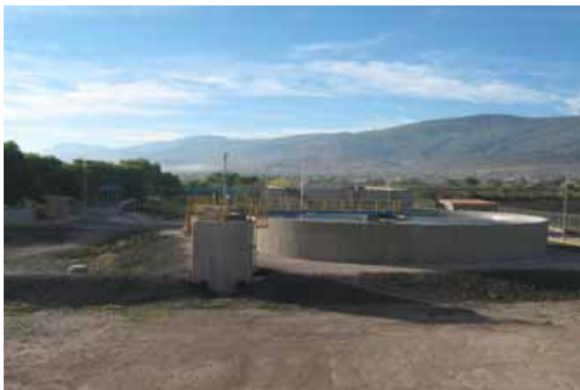
Planta de Tratamiento de Aguas Residuales en Tlajomulco
