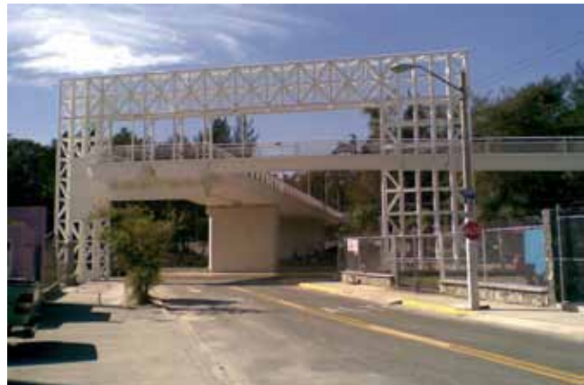
Puente peatonal concluido en el cruce Av. Patria y Eva Briseño
