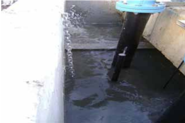
Obras Acondicionamiento para reducción de pérdidas
