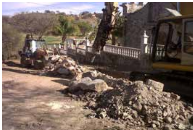
Excavación junto al Santuario
