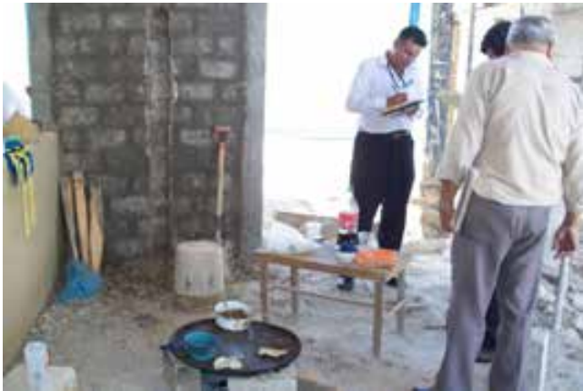
Obra en construcción en el municipio de Guadalajara, Jalisco.
