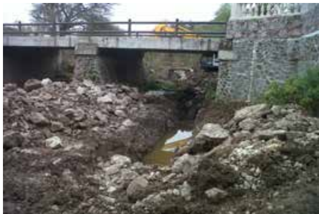
Excavaciones en colector Sagrada Familia
