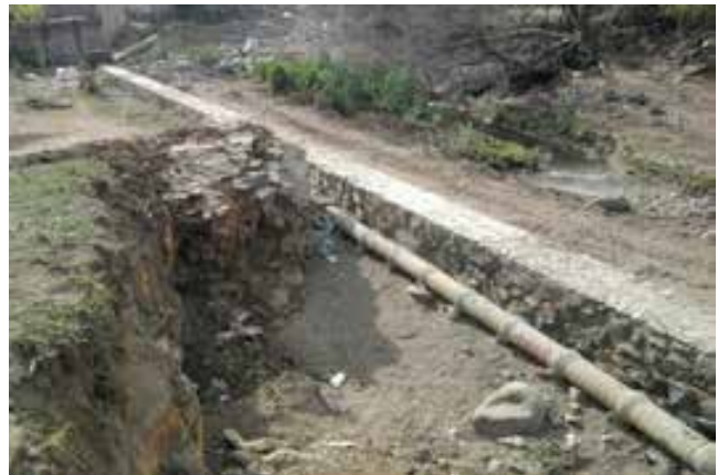
Obra realizada en la localidad de Santa Rosalía Municipio de Ayutla
