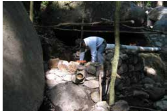
Obra realizada en la localidad de La Lima en el Municipio de Tolimán
