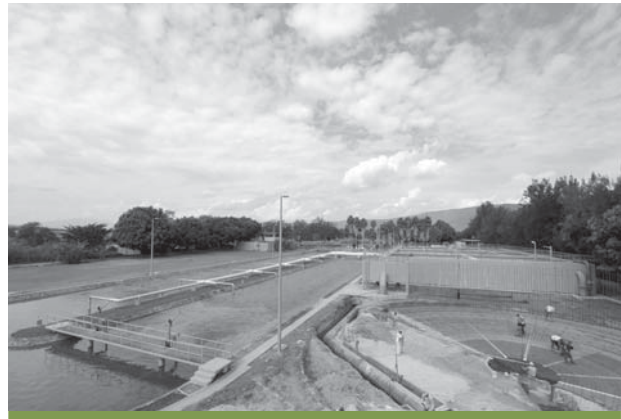
Planta de tratamiento de aguas residuales de Ocotlán
