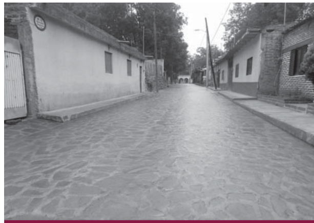
Obra de empedrado de calle
