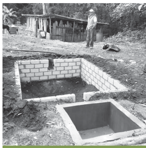
Instalación de biodigestores, Tamazula
