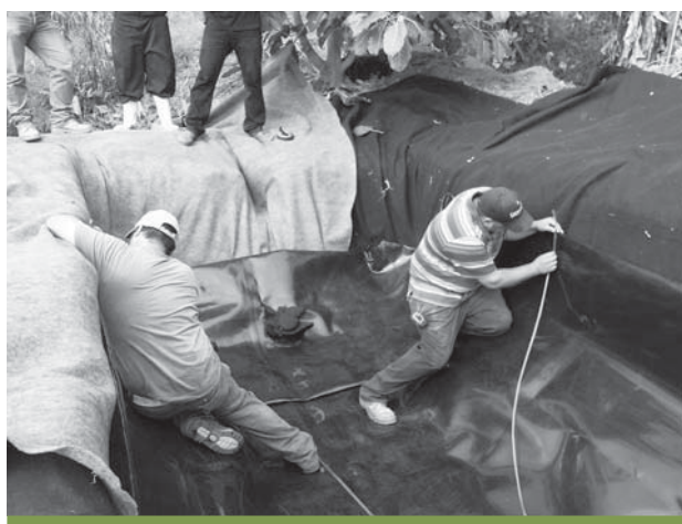
Instalación de biodigestores, Gómez Farías
