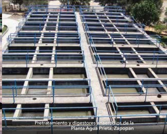
Pretratamiento y digestores anaerobios de la Planta Agua Prieta, Zapopan
