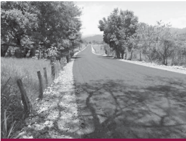
Pavimentación de carretera de acceso con recursos del Fondereg
