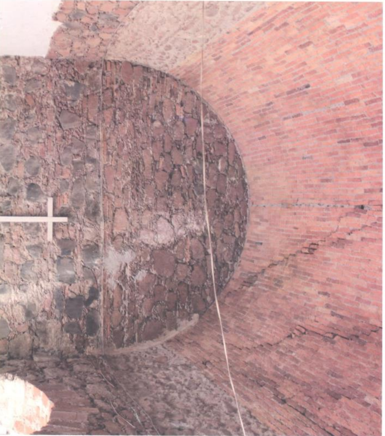
Vista interior de nave del Palacio Municipal
