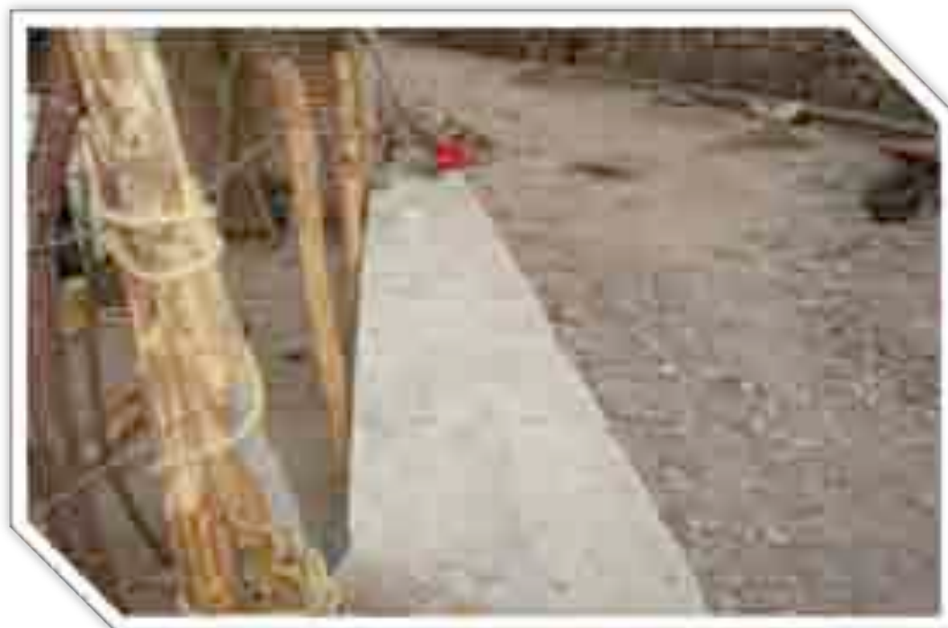
Imagen 139: Durante la obra IV.
