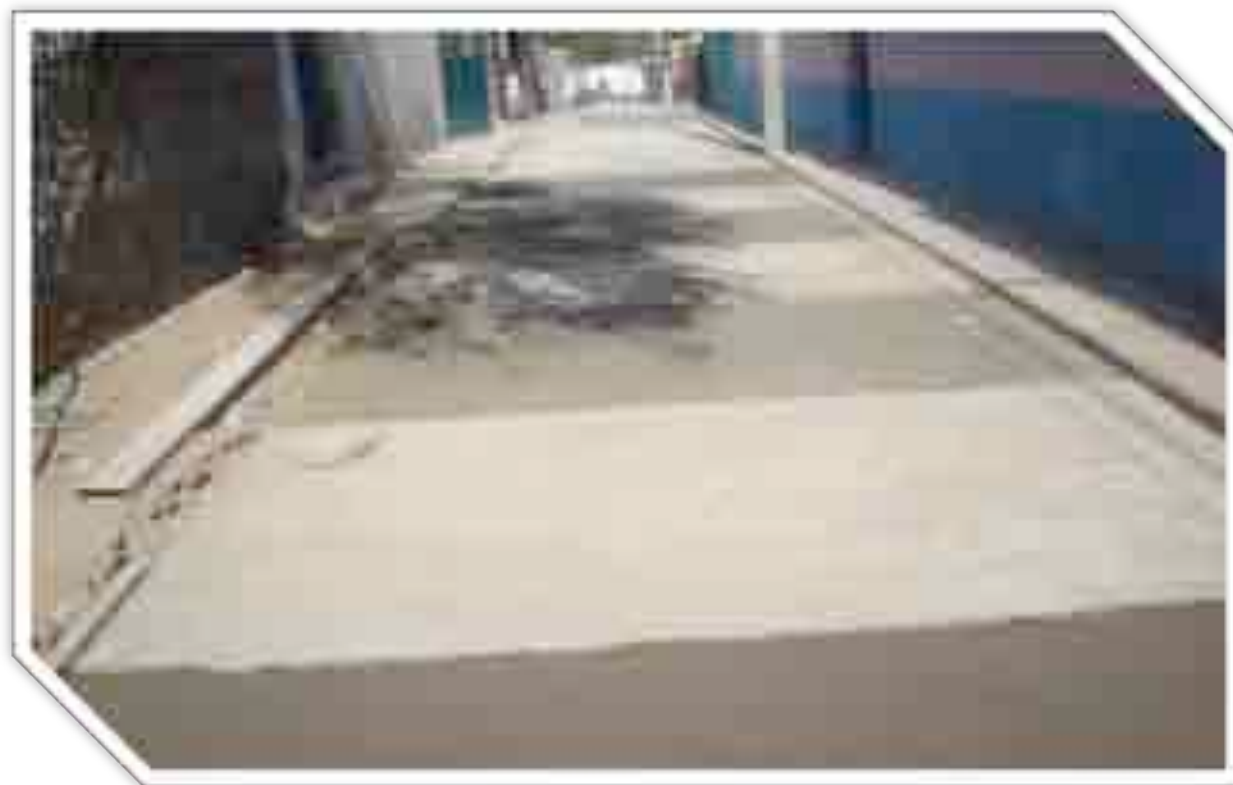
Imágen 112: Durante la obra III.
