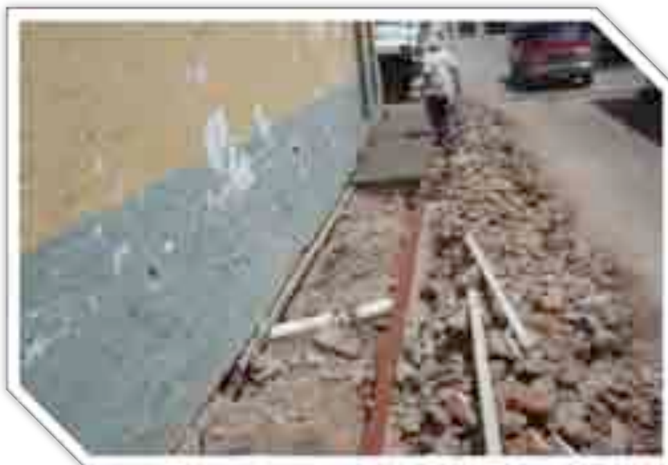
Imagen 116: Durante la obra II.
