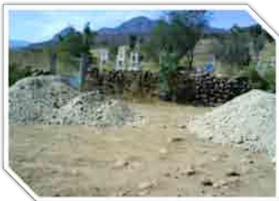
Imagen 93: Durante la obra III.
