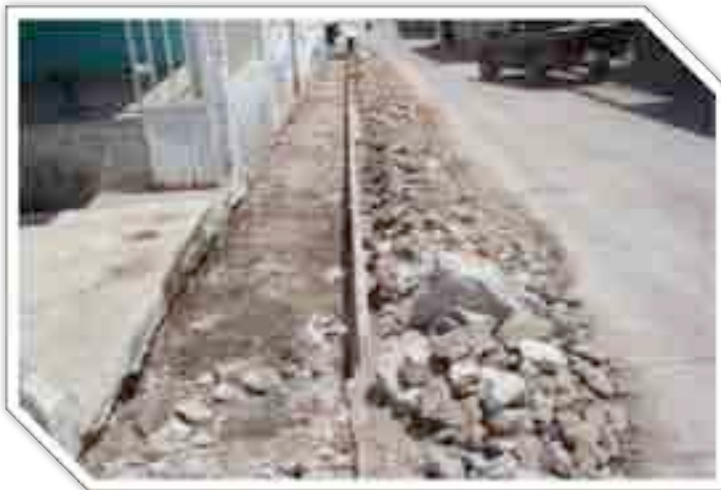
Imagen 115: Durante la obra I.
