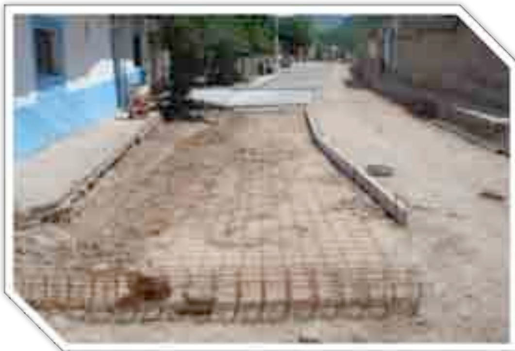
Imagen 47: Durante la obra.
