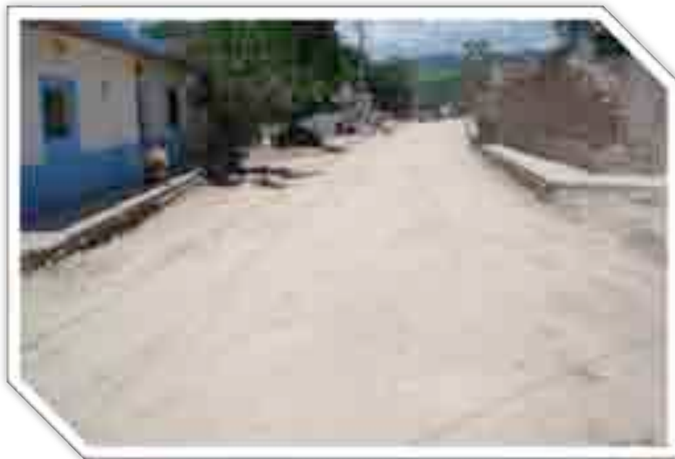
Imagen 46 Antes de la obra.
