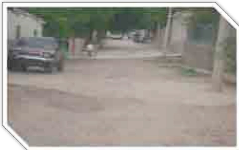
Imagen 53: Antes de la obra.
