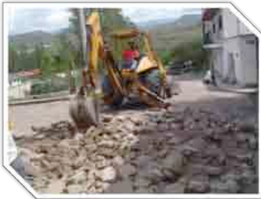
Imagen 43: Durante la obra.
