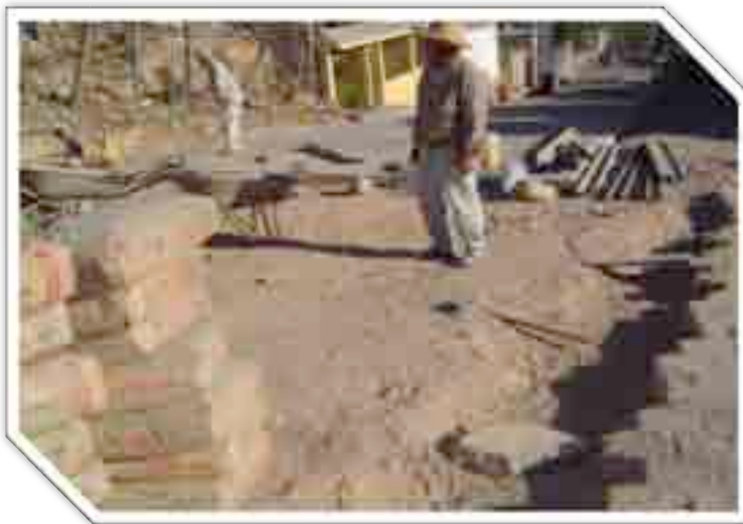
Imagen 107: Durante la obra II.
