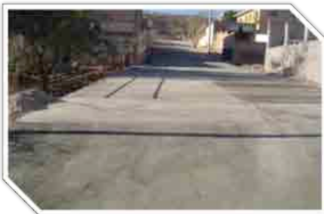
Imagen 108: Después de la obra I.
