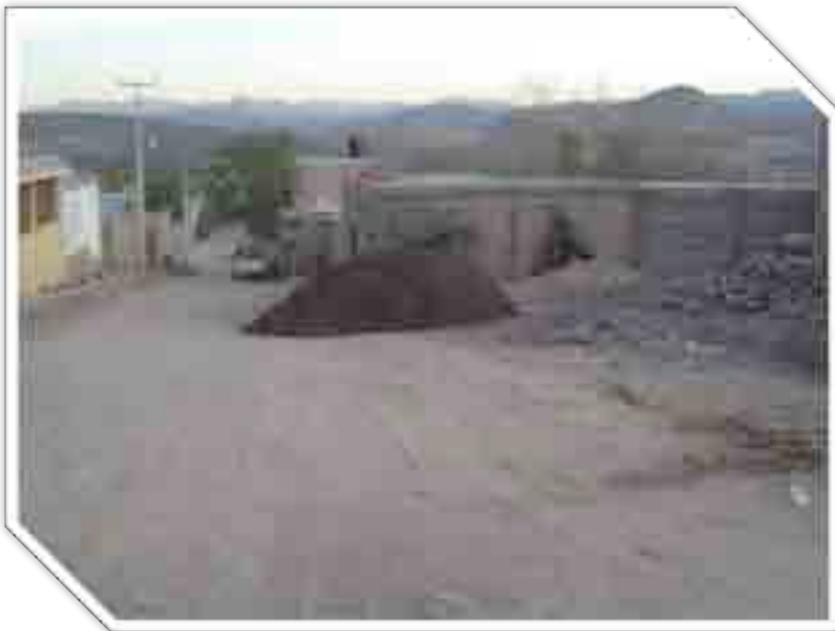
Imagen 104: Antes de la obras I.
