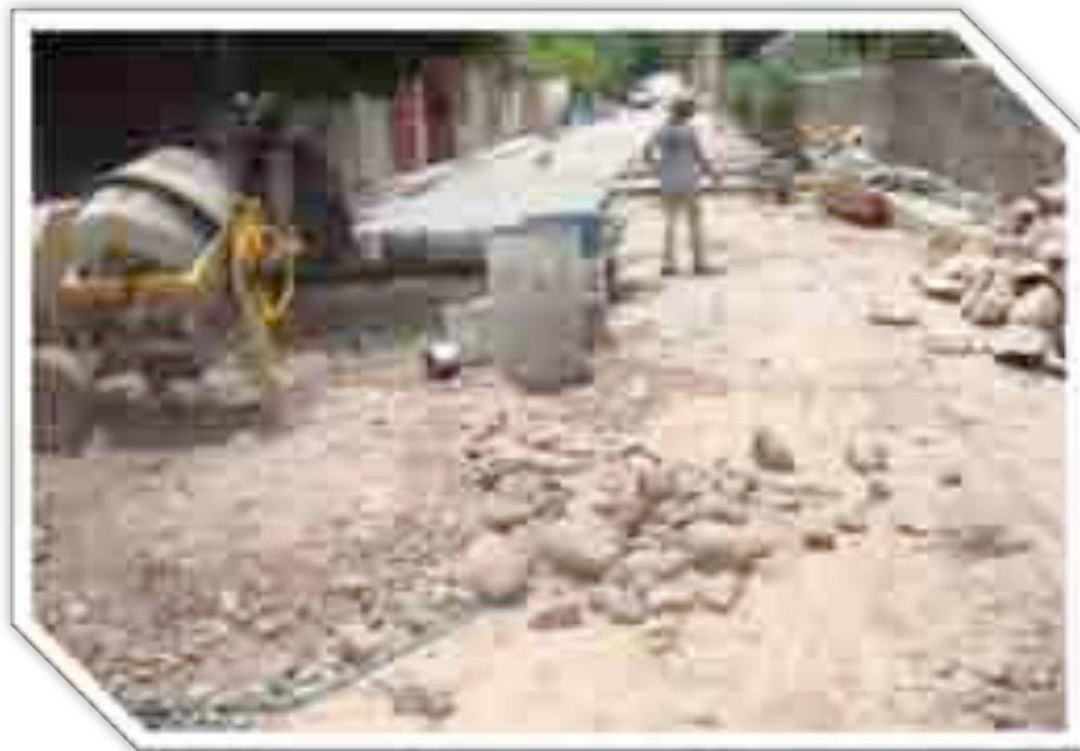
Imagen 56: Durante la obra.
