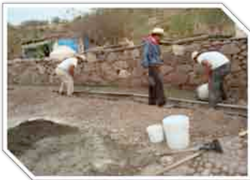
Imagen 137: Durante la obra II.
