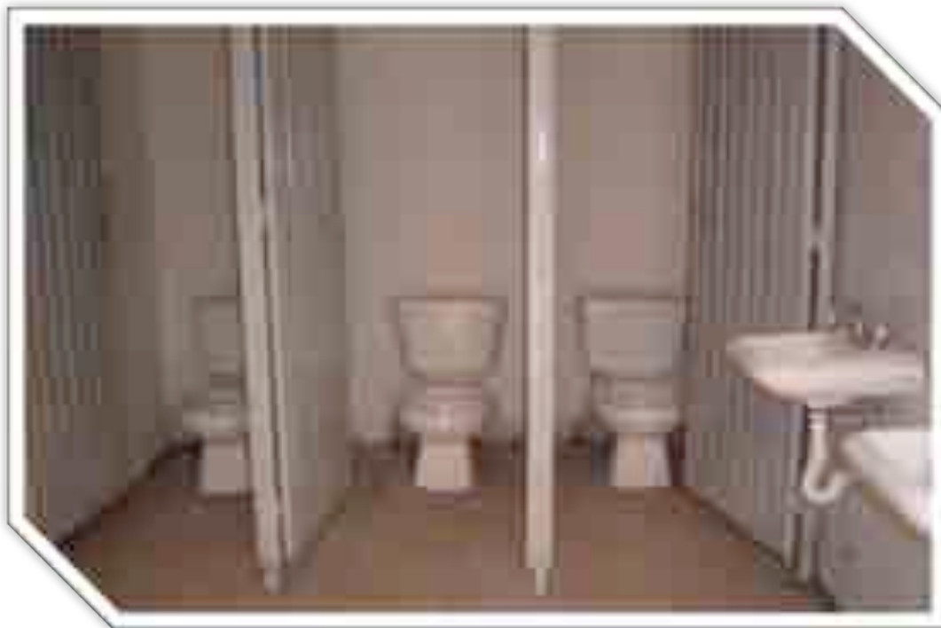
Imagen 127: Después de la obra I.
