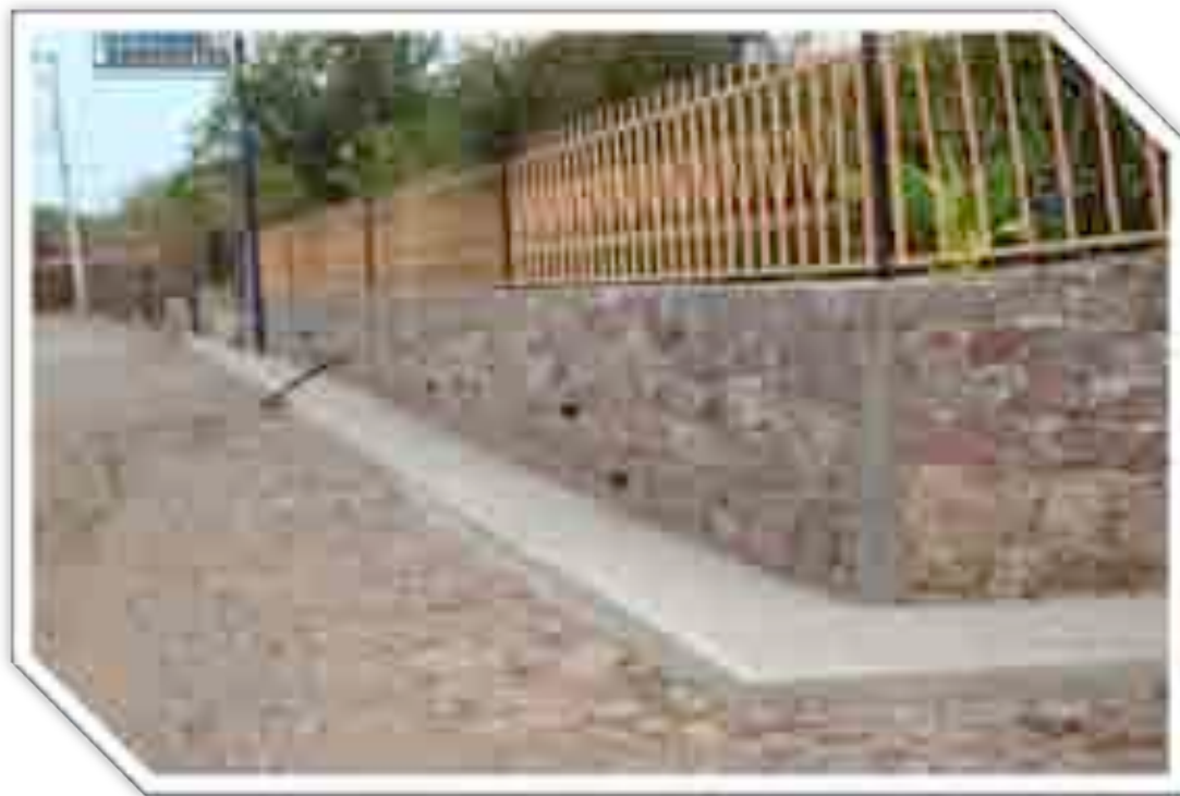
Imagen 140: Después de la obra I.
