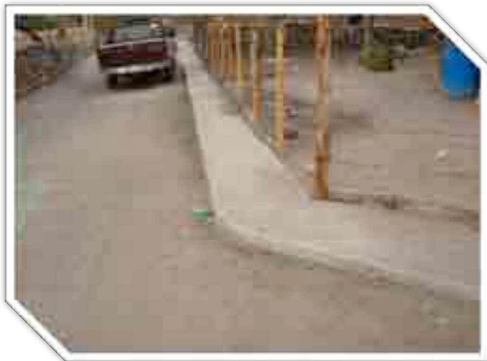
Imagen 143: Después de la obra IV.
