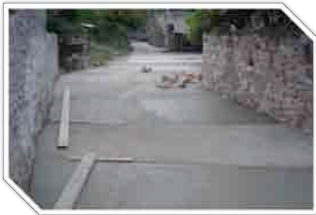
Imagen 84: Durante la obra II.
