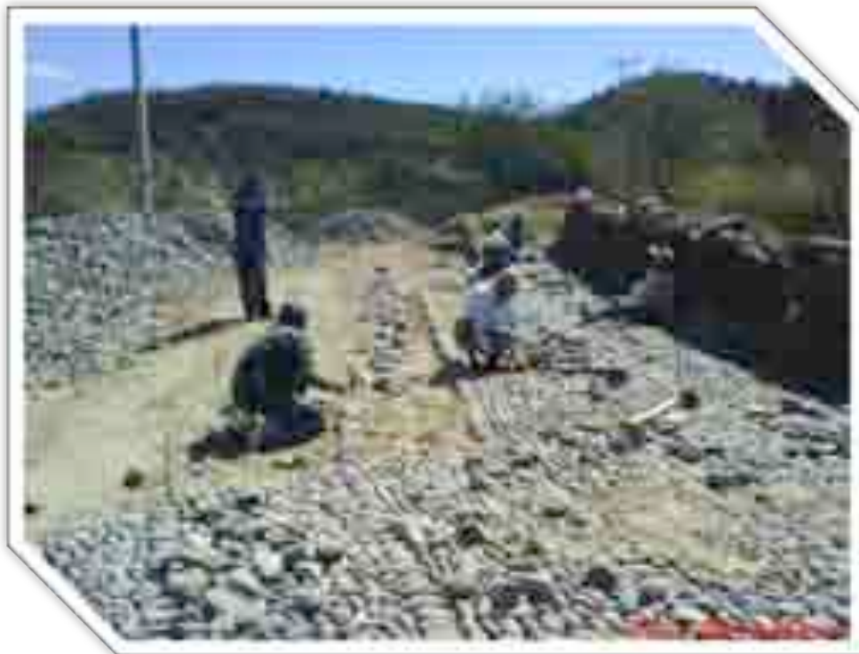
Imagen 62: Durante la obra.
