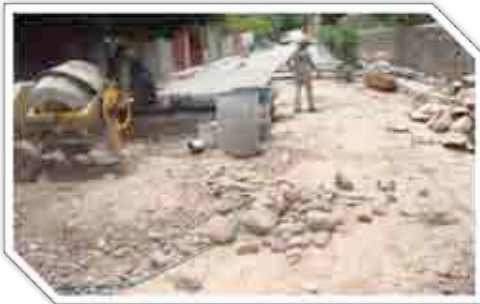
Imagen 54: Durante de la obra.
