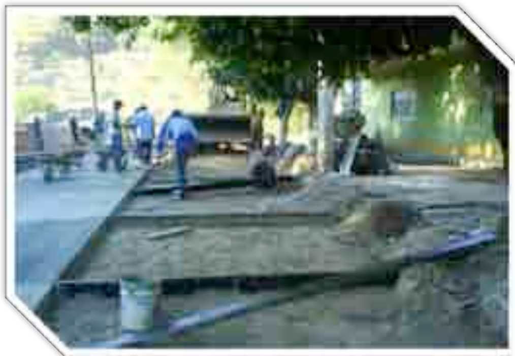
Imagen 121: Durante la obra I.
