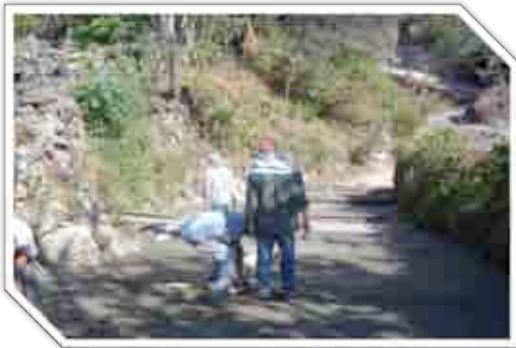
Imagen 66: Durante la obra II.
