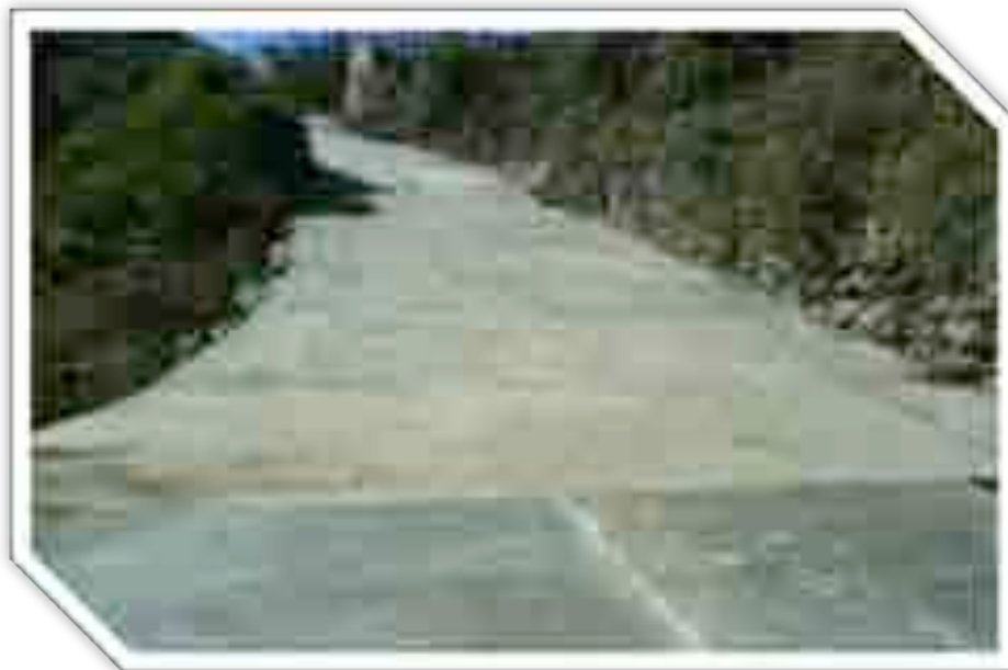
Imagen 74: Después de la obra I.
