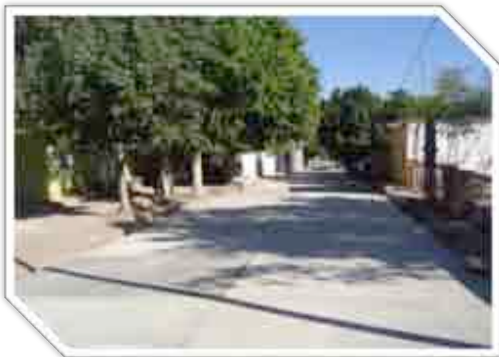
Imagen 123: Después de la obra I.
