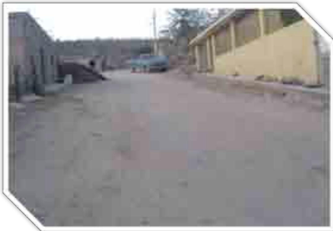
Imagen 105: Antes de la obra II.
