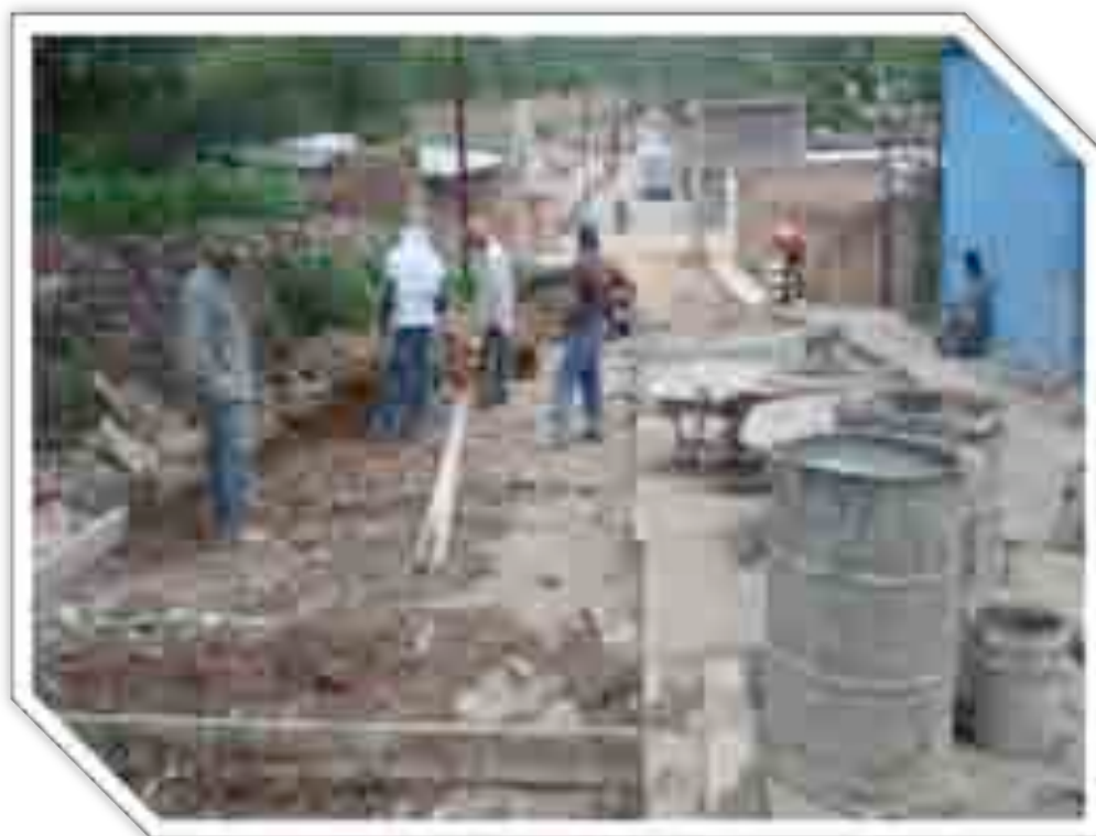
Imagen 59: Durante la obra.
