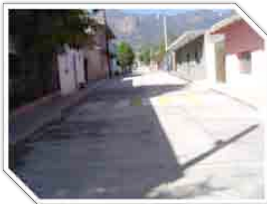
Imagen 44: Después de la obra.
