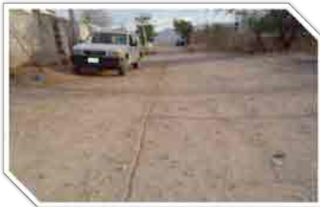
Imagen 129: Antes de la obra II.
