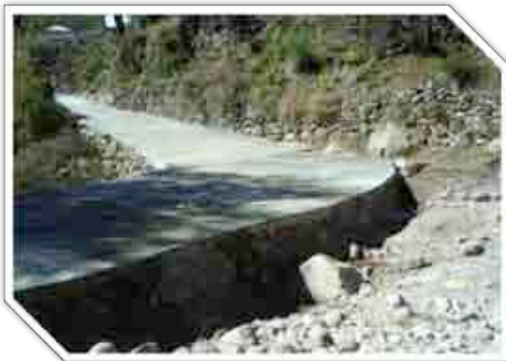
Imagen 68: Después de la obra I.
