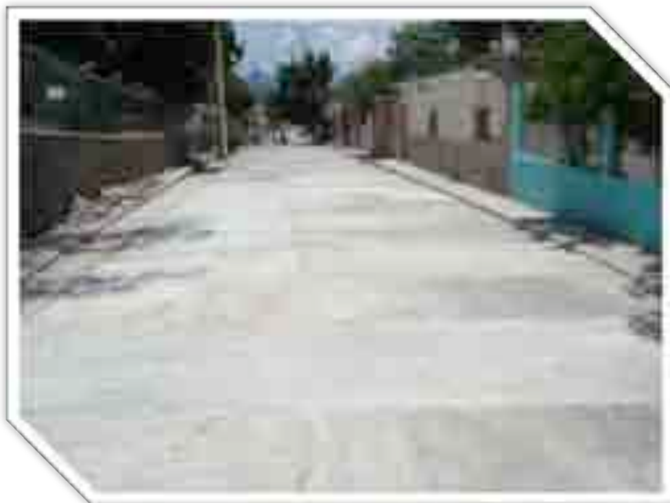
Imagen 57: Después de la obra.
