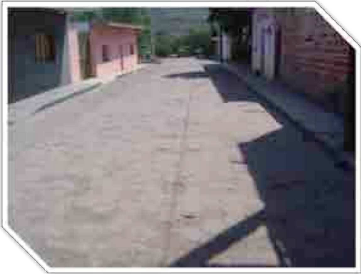
Imagen 42: Antes de la obra.
