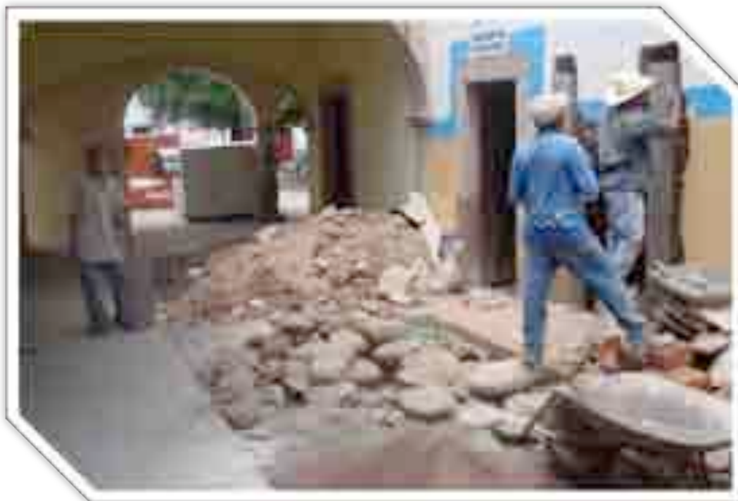
Imagen 126: Durante la obra I.
