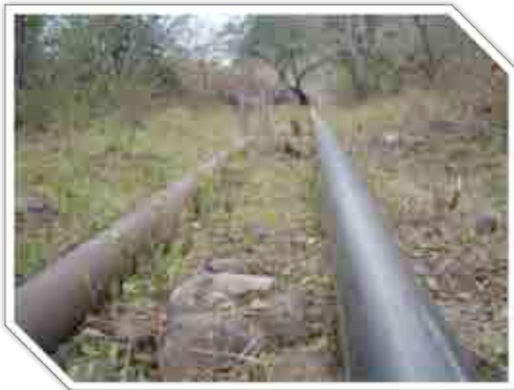
Imagen 98: Después de la obra I.
