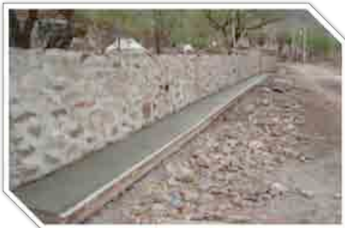
Imagen 138: Durante la obra III.
