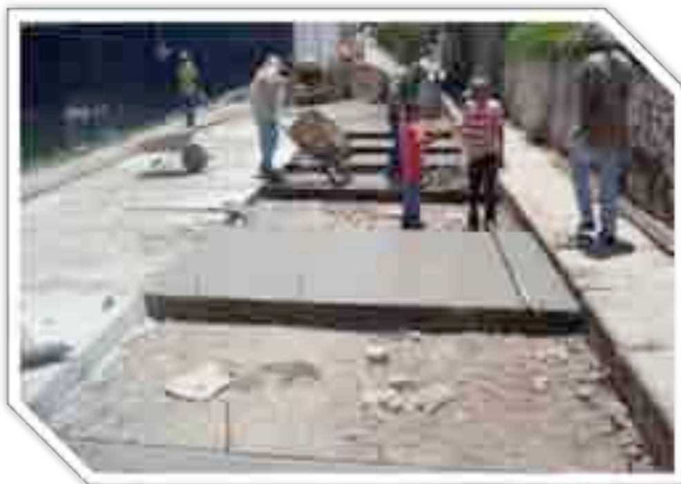
Imagen 50: Durante la obra.
