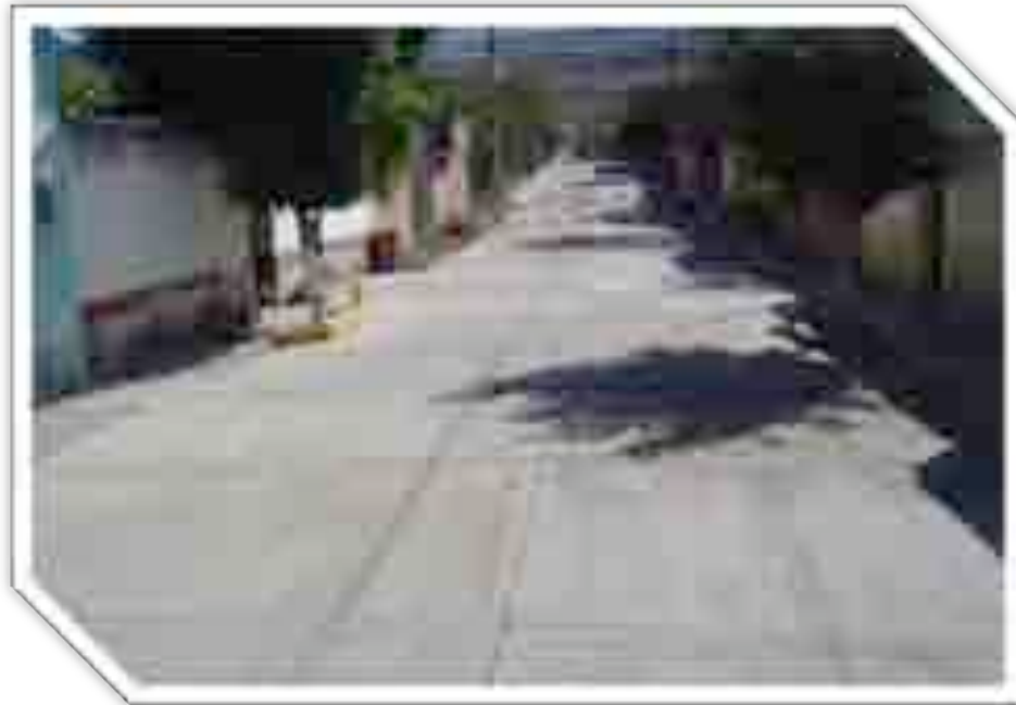
Imagen 45: Después de la obra II.
