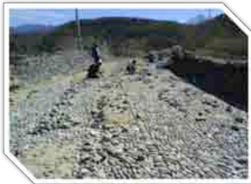
Imagen 94: Durante la obra IV.
