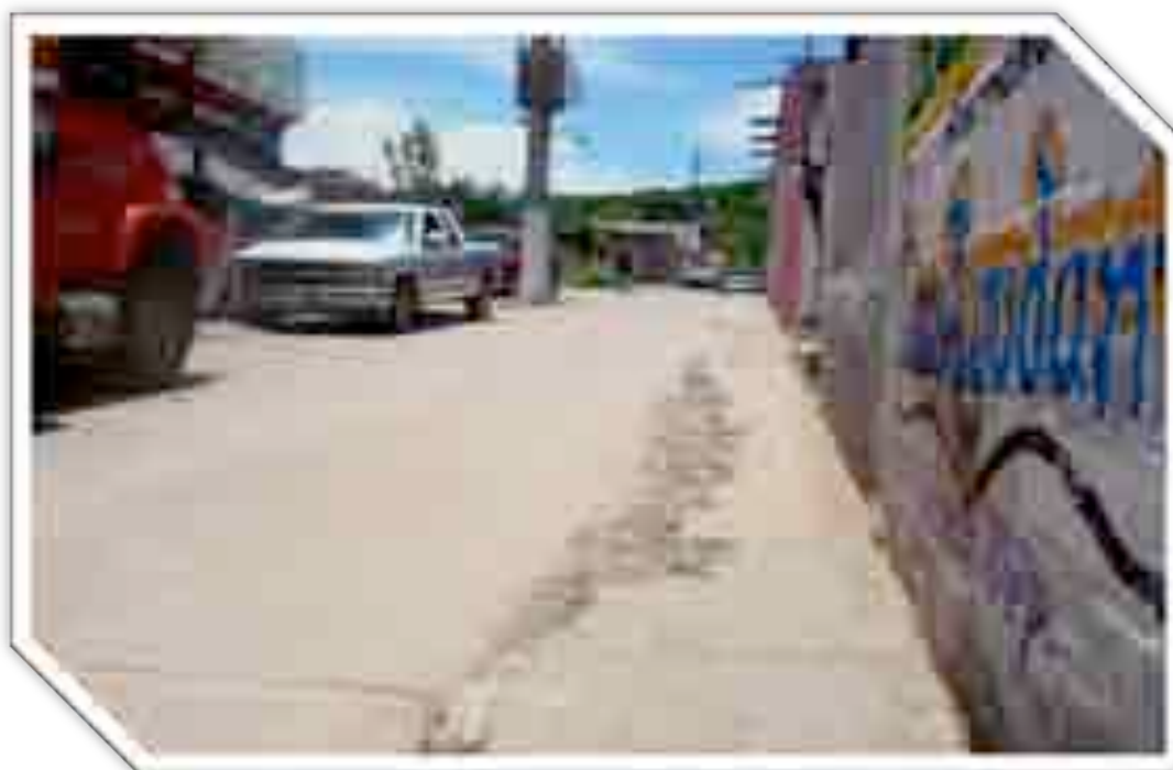
Imagen 114: Antes de la obra II.
