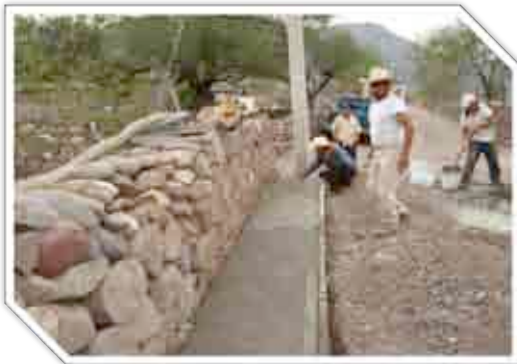
Imagen 136: Durante la obra I.
