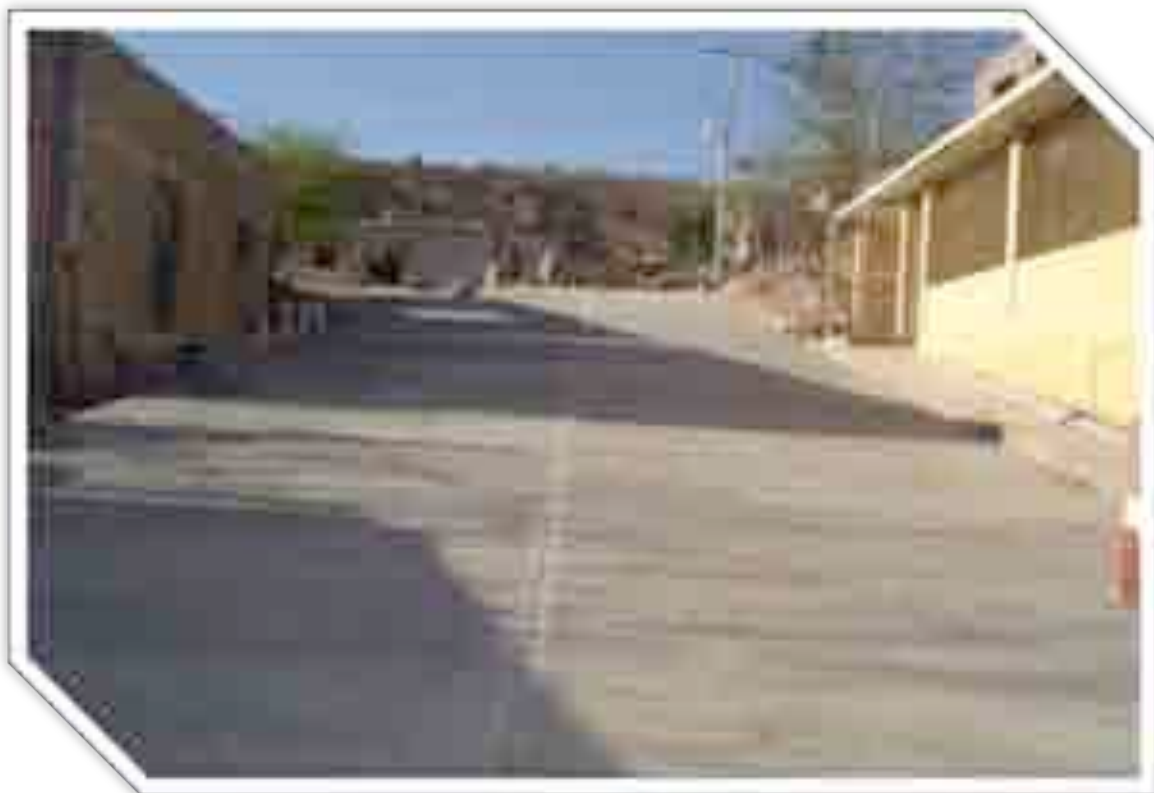
Imagen 109: Después de la obra II.
