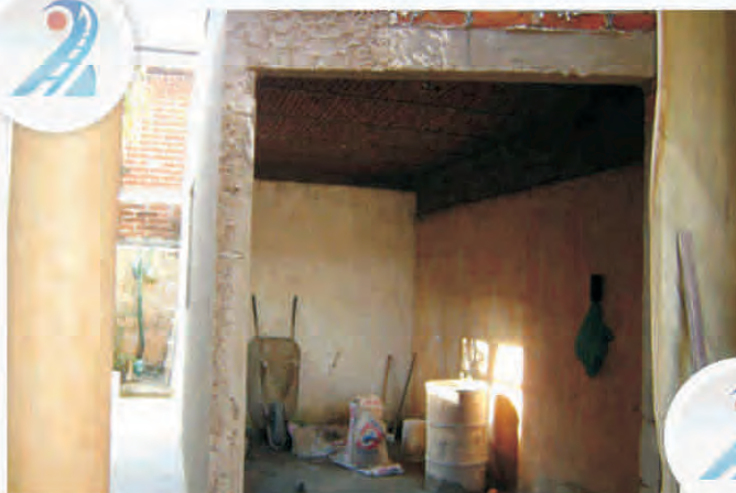
CONSTRUCCION DE BODEGA EN DIF SANTIAGUITO
