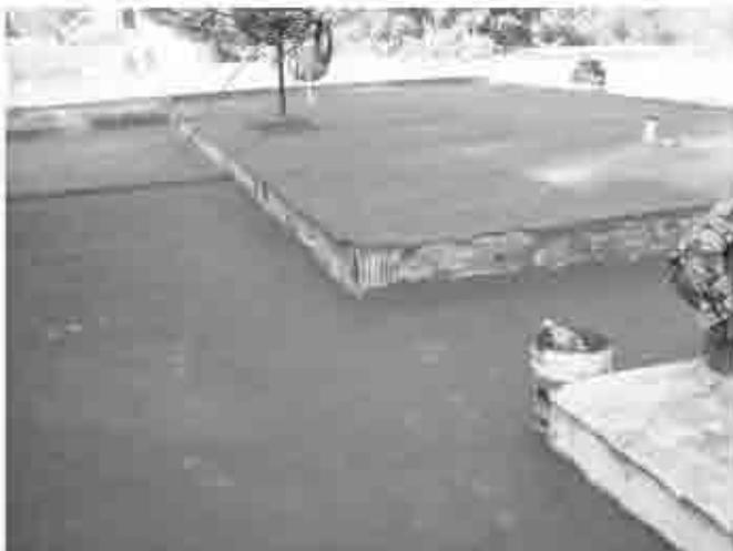
Arreglo total del andador pepa villa que consta de elaboración de machuelos, colocación de adoquín, elaboración de banquetas, aplicación de pintura, con un costo de \$17,000 pesos.
