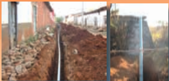
Construcción de Alcantarillas, programa INFRA $107,280.42 CONCLUIDA
