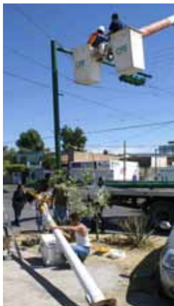
Instalación de Semáforos
