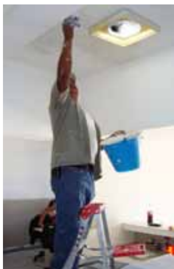
Mantenimiento a oficinas
