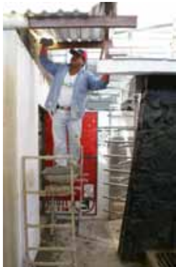
Construcción de baños para discapacitados
