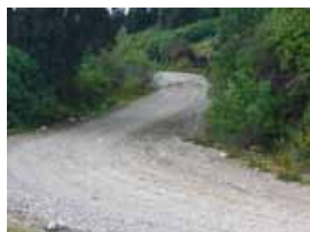
Rehabilitado de brecha km. 16
