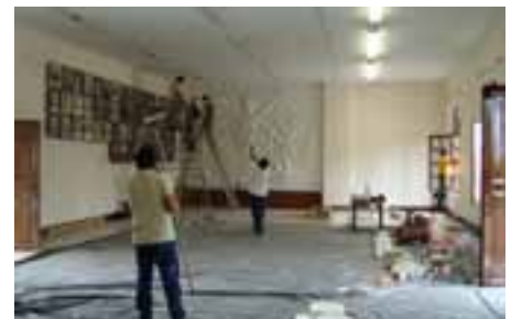
Mantenimiento general de Sala de Ayuntamiento
