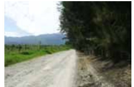
FISE Rehabilitación brecha al Nevado
