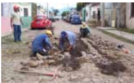
Empedrado en calle Privada Guerrero
