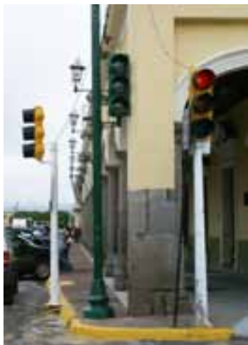
Instalación de Semáforos
