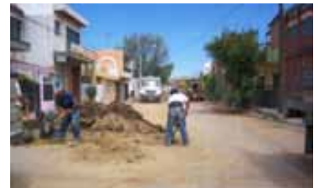
Obras en calle Nayarit
