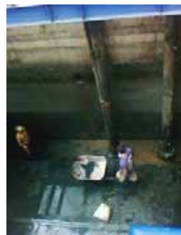
Limpieza de Pozo
