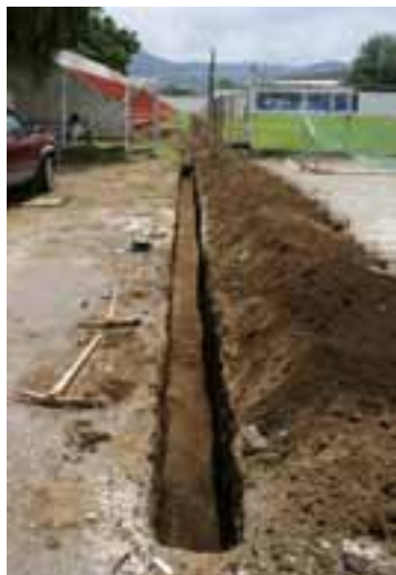
Obras de impermeabilización y nuevo drenaje en Estadio Santa Rosa
