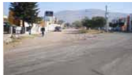
Pavimento asfáltico en Av. Serafín Vázquez
