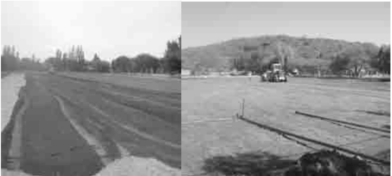
Cancha de fut-bol La Puerta de Cítala 140 viajes de tierra y 100 viajes de balastre y el trabajo de la motoconformadora.
