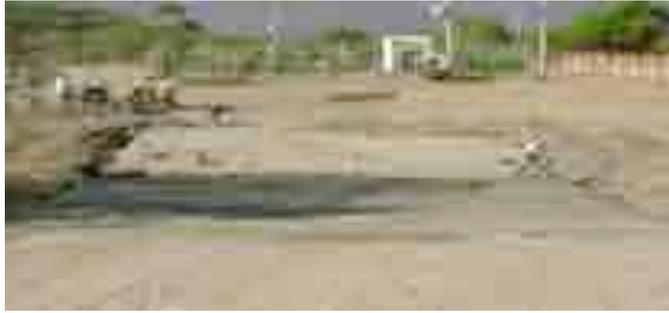
3. Se amplió la rampa de acceso al vado del río de “La Cofradía”, con el fin de mejorar la circulación de los camiones pesados.
