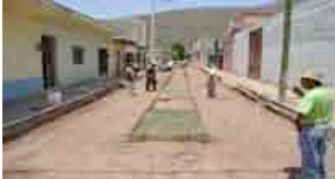
2.- Construcción de Huellas de Rodamiento y Empedrado Ahogado en Cemento (Cambio de Red de Agua y Drenaje) en la calle Matamoros. Con un costo de \$371,450.00
