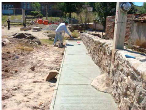
Construcción de Banquetas
