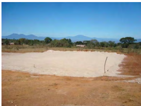
Construcción de Cancha de Usos Múltiples
