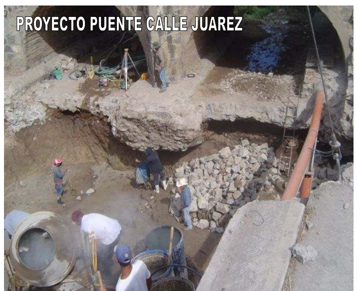
NOTESE EL CIMIENTO TAN POCO PROFUNDO QUE SE ENCONTRÓ Y QUE ESTAMOS REFORZANDO
