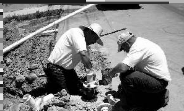
Personal de la dependencia en colocación de Válvulas
