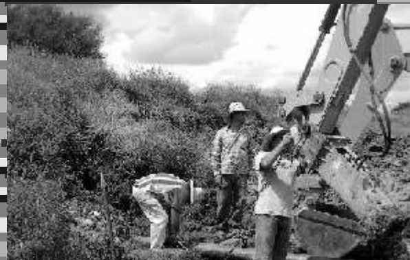
Instalación de red de agua potable
