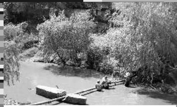
Arreglo de tubería de agua potable
