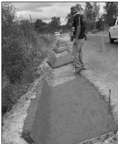
Arreglo de cunetas en caminos
