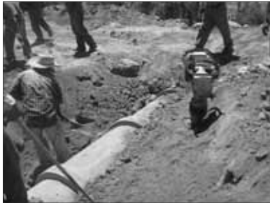
• Instalación de tubos de desazolve de aguas pluviales en el camino a Barbechitos
