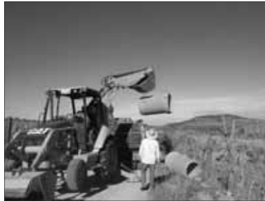
• Instalación de tubos de desazolve de aguas pluviales en el camino a Barbechitos
