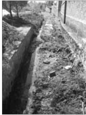
• Limpieza de alcantarillas, y bocas de tormenta.
