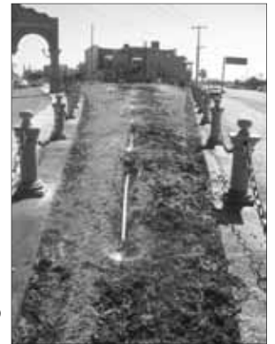
• Instalación de riego por aspersión automatizado en la fuente de ingreso.
