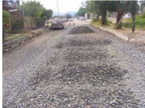
Obra base en proceso de pavimentación.
