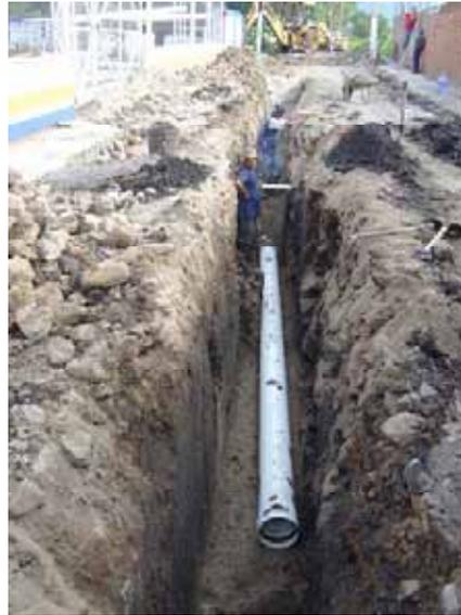
**Reconstrucción de colector pluvial** en calle Ramón Corona.
