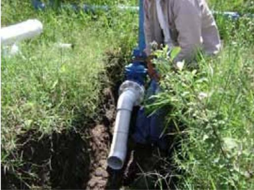
**Construcción de Red de Drenaje** en la comunidad de La Tiricia con tubería de Polietileno a base de 12" con una longitud de 430 metros. La obra fue ejecutada al 100% por parte del gobierno municipal con un costo total de \$ **196,109.09**.
