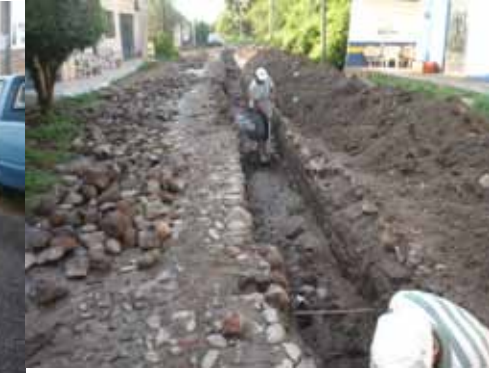
Reparación Drenaje Cofradía
