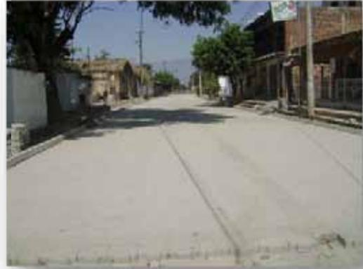
d).- Reposición de empedrado por concreto hidráulico reforzado con varilla de 3/8 y cambio de la red de alcantarillado sanitario y descargas domiciliarias en la calle Guzmán entre Abasolo y Ocampo. Con un costo total de \$ 1, 800,044.41 con un costo total de estas obras de \$ 9, 113,743.21 con la participación del gobierno del estado y el municipio
