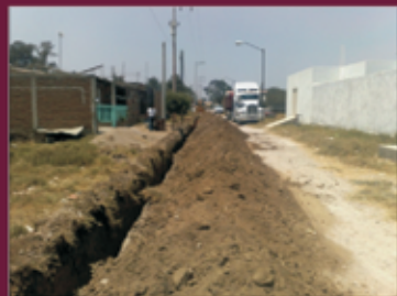
Construcción de redes de agua potable
