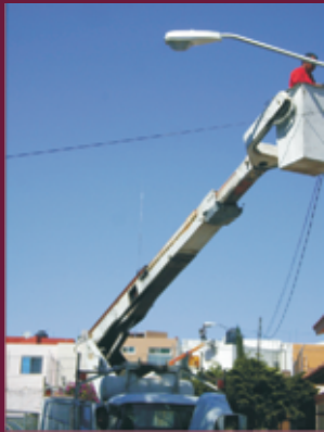
Cambio de luminaria
