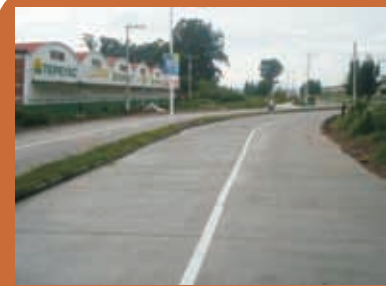
Concreto hidráulico en Avenida Pedro Ramírez Vázquez
