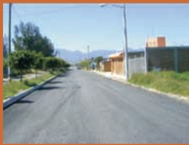
Pavimento asfáltico calle El Grullo
