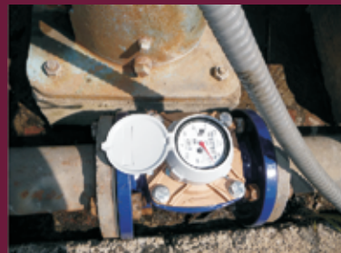
Detección de fugas
