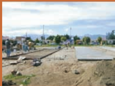
Cancha de usos múltiples en el fraccionamiento Las Azaleas
