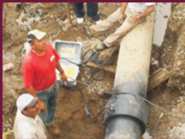
Detección de fugas
