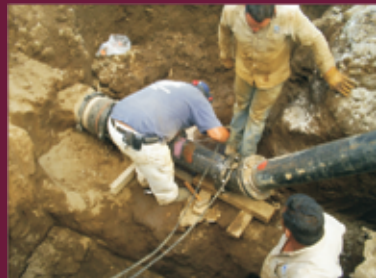
Mantenimiento a pozos de agua
