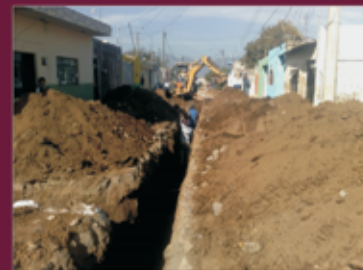
Construcción de redes de agua potable
