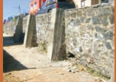
Muro de contención y contrafuerte en calle Lázaro Cárdenas
