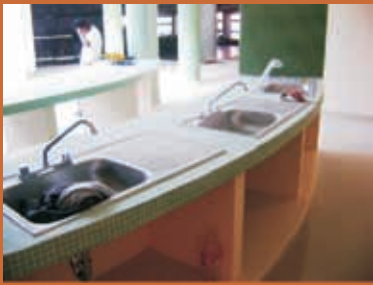
Remodelación de cocina del Casino Auditorio
