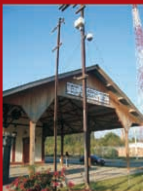
Cámara de video vigilancia
