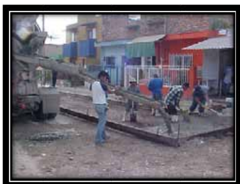
Pavimento de concreto hidráulico en calle Ma. Reyes Quintero, Juan González y Amelia Magallanes en col. ISSSTE 2'073,172.00
