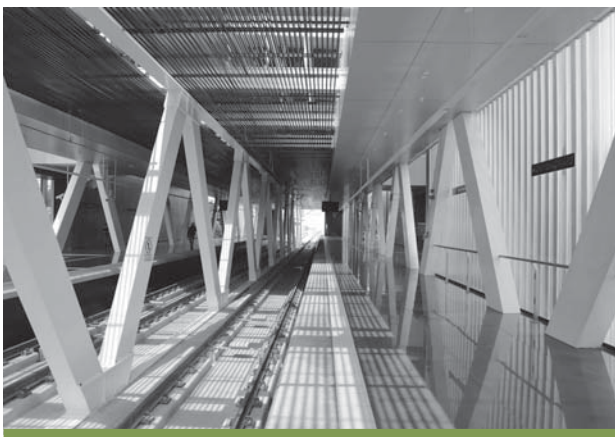
Estación Plaza Revolución Viaducto 2, Guadalajara
