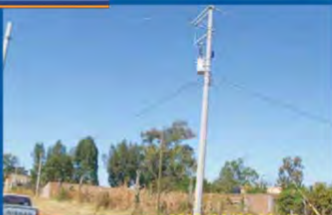
Electrificación calle Galeana
