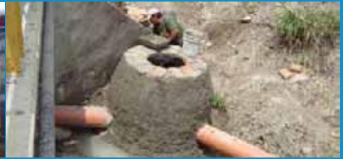
6. Conexión de 110 m. para unir las descargas de drenaje al Colector del Arroyo las Canteras.
