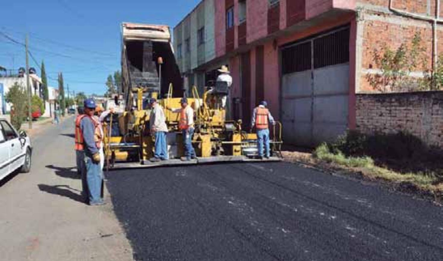
En la calle Pipón, fue colocada la carpeta asfáltica de 7 centímetros de espesor en una superficie de 5 mil 383 metros cuadrados, cuya inversión fue de 1 millón 136 mil 562 pesos.
