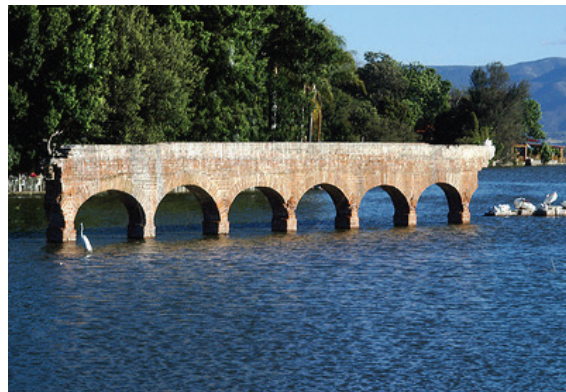
La presa de la Vega se encuentra en el municipio de Teuchitlán, Jalisco, al Oeste de la Perla Tapatía
