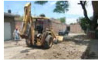
Se realizó la instalación de la línea de drenaje sanitario en Calle Rio Blanco de la Colonia San Javier a base de tubería de PVC 8", con una longitud de más de 72 mts, ya que no contaban con este servicio tan indispensable. Con costo de \$ 6,340.00 (seis mil trescientos cuarenta pesos 00/100), recursos aportados en su totalidad por este organismo.
