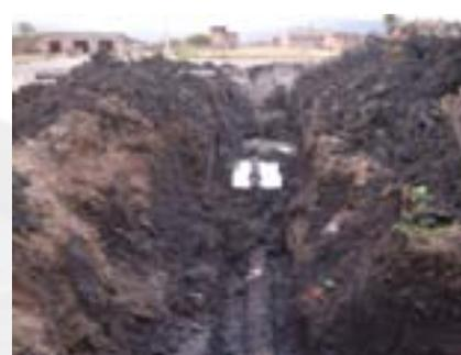
En la parte del interior de la cabecera **69** se han reparado y sustituido tomas domiciliarias de agua, debido al desgaste por el tipo de material con el que cuentan.
