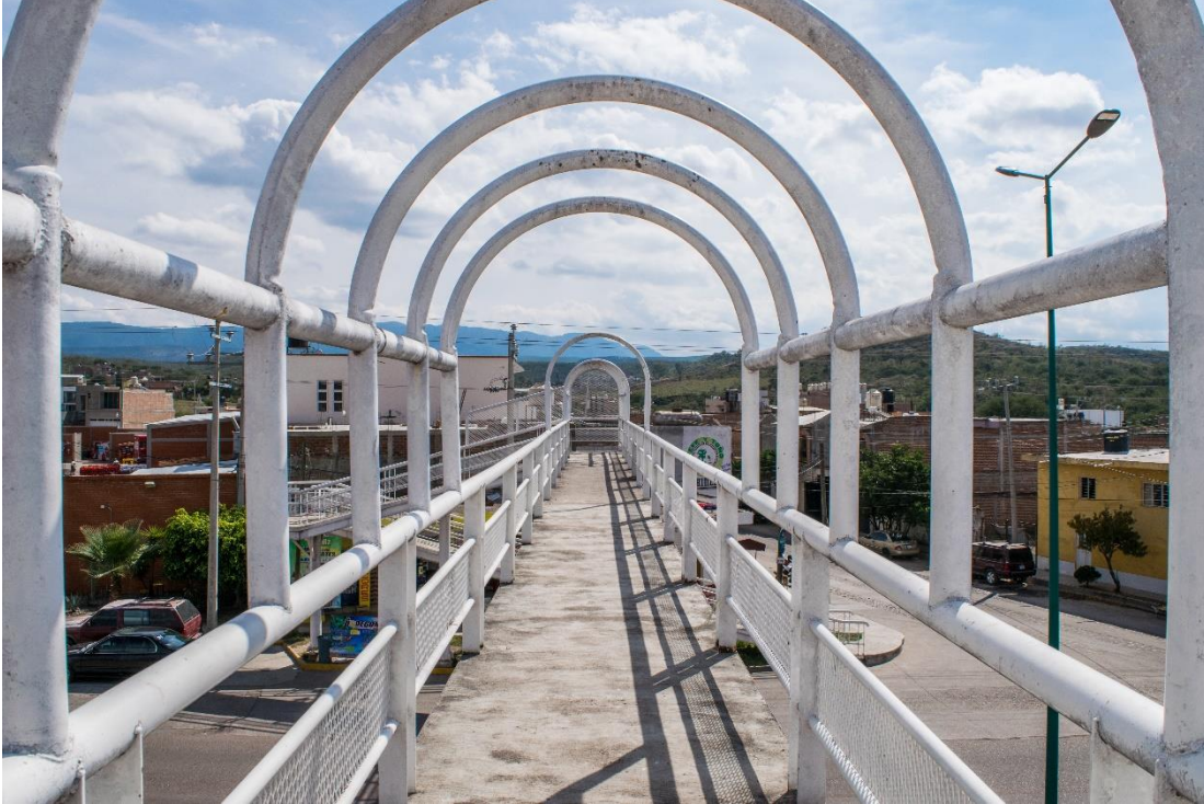
Puente Peatonal, Colotlán Jalisco. Fotografía del Archivo Municipal, 2022.
