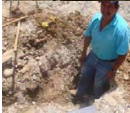
Reparación de Fugas y red de tanque "lagunitas".
