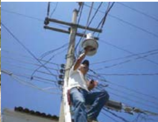
◀ El Departamento de Alumbrado Público ha colocado 150 lámparas suburbanas en todo el municipio.
