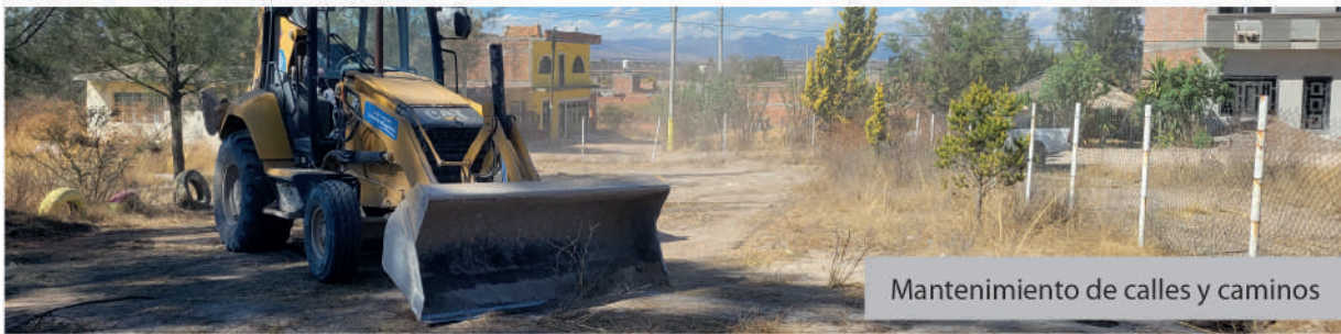
Remodelación calle Hidalgo salida a Ags.
