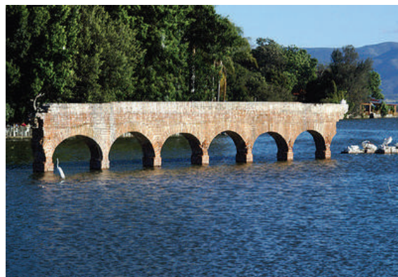
La presa de la Vega se encuentra en el municipio de Teuchitlán, Jalisco, al Oeste de la Perla Tapatía
