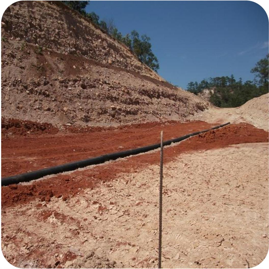
Se instalaron chimeneas para los gases de efecto invernadero y drenaje para los lixiviados y su fosa.
