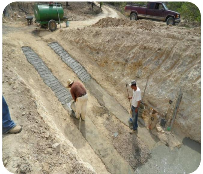
Después de la construcción de la fosa se recubrió con geomembrana de 1mm de espesor, esto con el fin de evitar la contaminación de los mantos freáticos.
