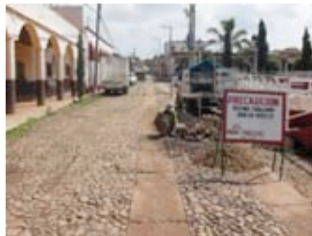
Bacheo de carretera
