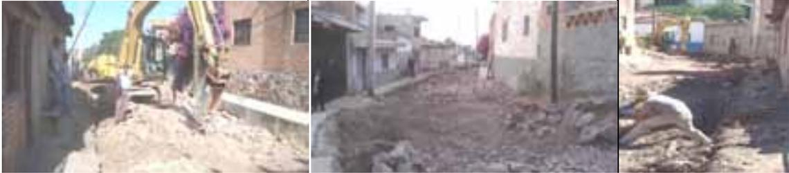
La sustitución del empedrado existente por un nuevo, el cual será lechereado con concreto y llevará huellas de adoquín.
