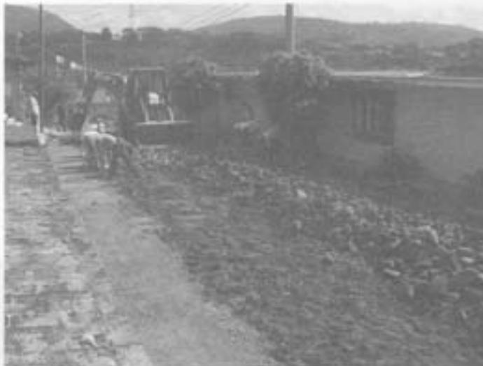
CONSTRUCCIÓN DE CONCRETO ESTAMPADO EN CALLE VENUSTIANO CARRANZA Y JUAREZ, EN MIRAVALLE, MONTO \$384,213.50, META 730.00 M<sup>2</sup>. CONSTRUCCIÓN DE LINEA DE DRENAJE DE 12", MONTO \$184,358.48, META 96.00M<sup>2</sup>, BENEFICIARIOS 1,500. MONTO TOTAL \$568,571.98.
