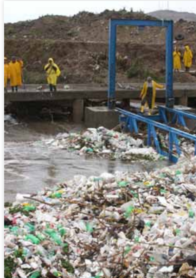
Trabajos de limpieza
