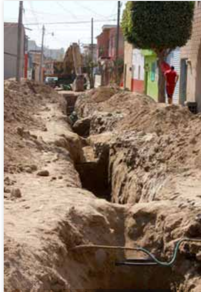
Sustitución de la red de agua potable en la calle Pedro Loza, San Agustín
