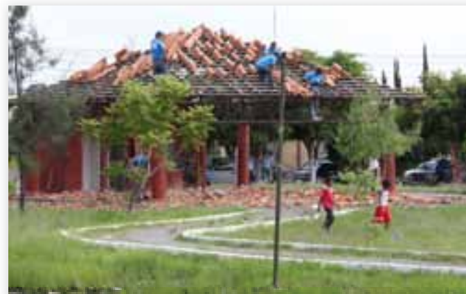
Avance en la construcción del Centro Recreativo Familiar de Rancho Alegre
