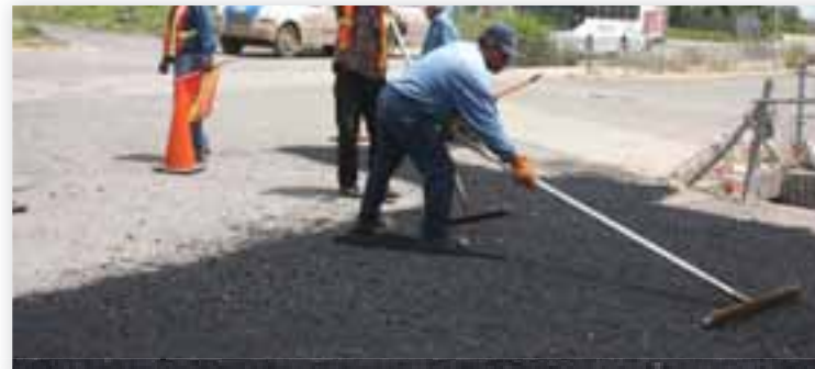
Trabajos de bacheo en Chulavista
