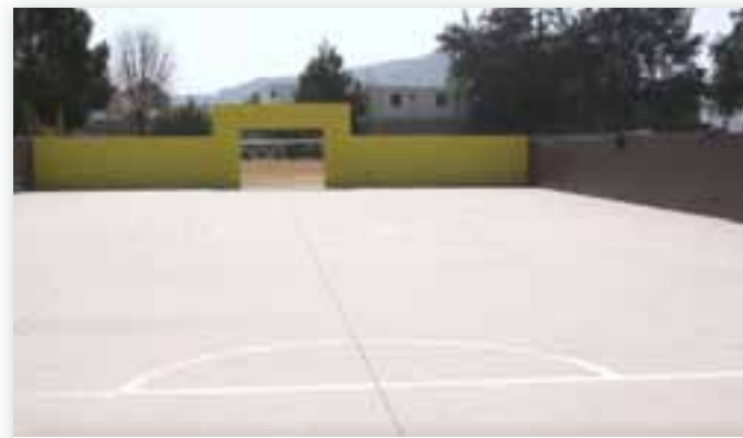
Progreso en la construcción de unidad deportiva
