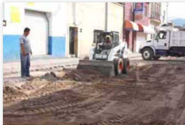
Trabajos de repavimentación
