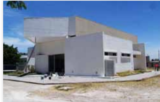
Adecuaciones para el refugio temporal de Tulipanes
