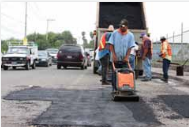
Trabajos de bacheo
