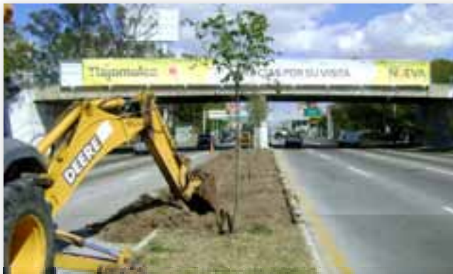
Rehabilitación de Avenida López Mateos
