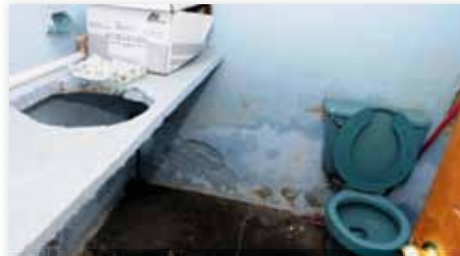
Baño de la Dirección de Agua Potable y Alcantarillado, enero 2010
