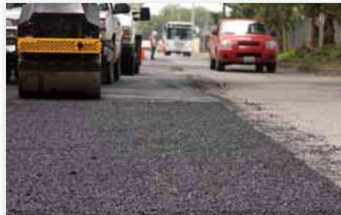
Trabajos de bacheo
