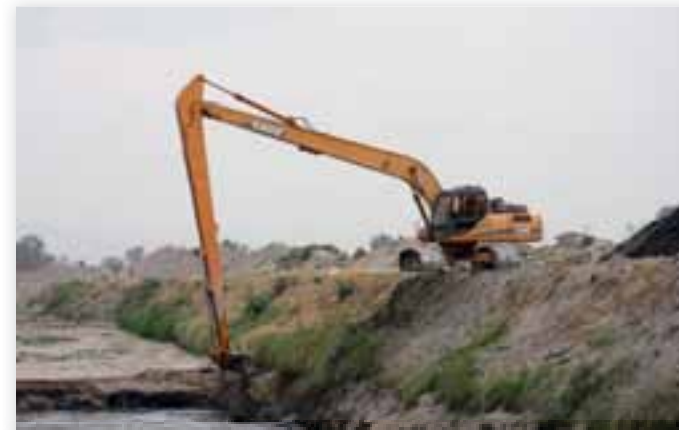
Trabajos de desazolve en el Canal de las Pintas
