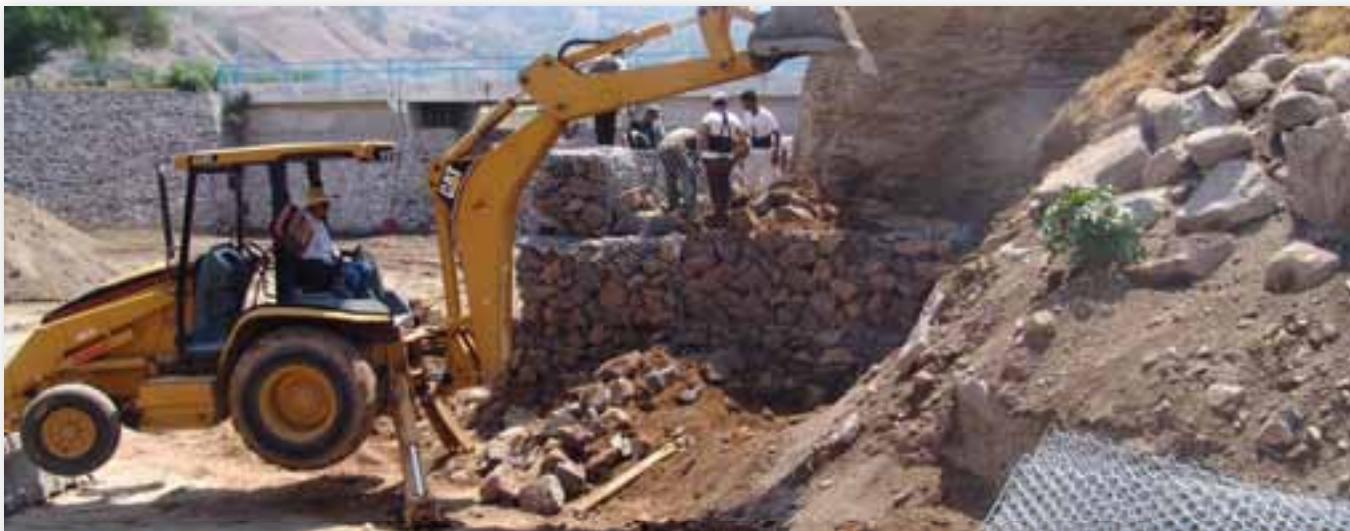
Obras en el vaso regulador El Cónico
