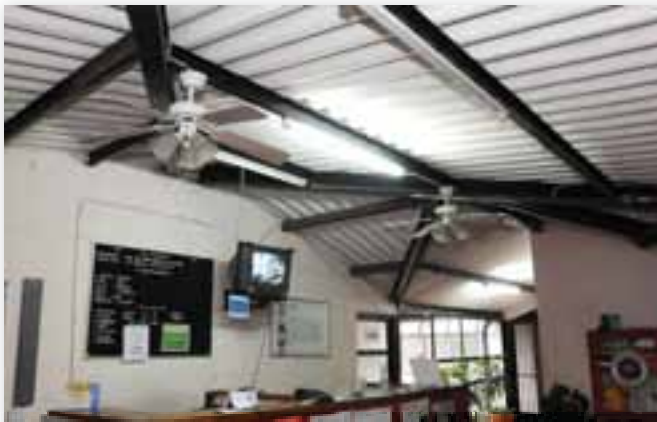
Techo de asbesto del antiguo edificio del DIF, enero de 2010
