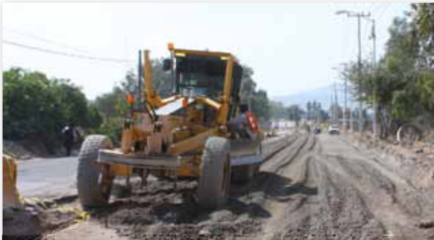
Obras en Prolongación Colón
