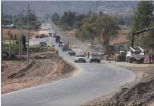
Obras en el Circuito Sur
