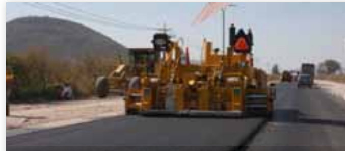
Obras en el Circuito Sur
