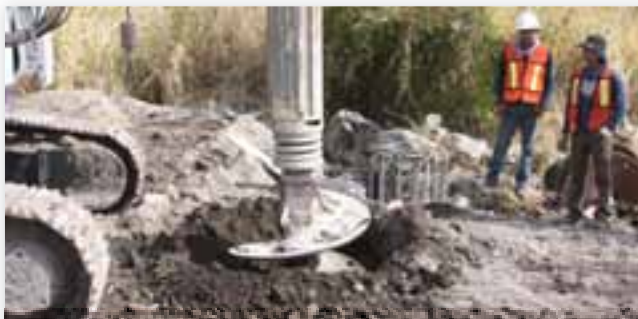
Arranque de las obras del Nodo Aeropuerto Sur (VFG)
