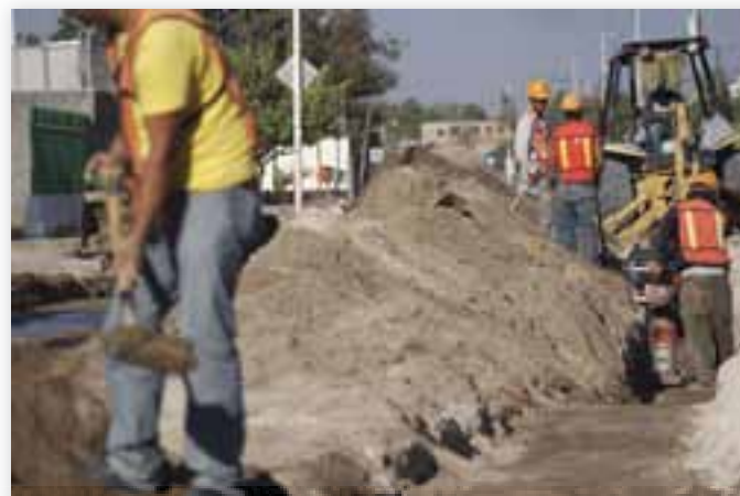
Obras en el Camino a Los Ocotes
