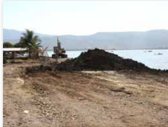
Obras de construcción del Malecón de Cajititlán
