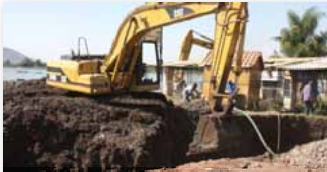
Obras de construcción del Malecón de Cajititlán
