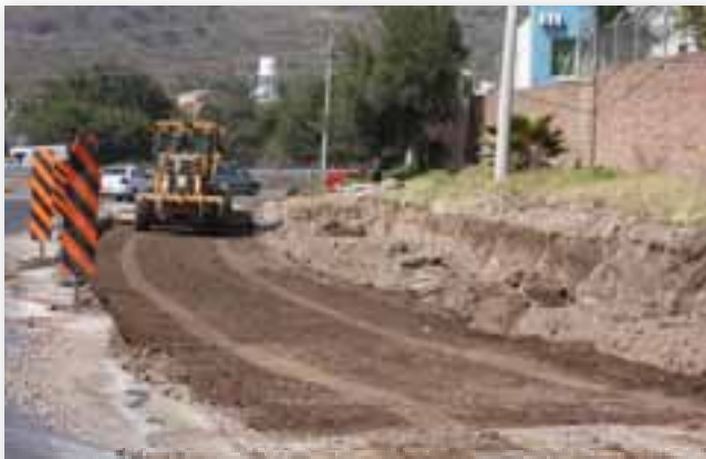
Obras en el Nodo Las Cuatas
