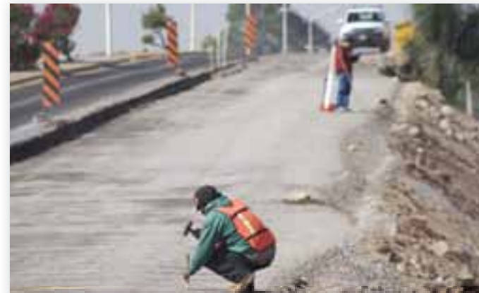
Obras en el Nodo Las Cuatas
