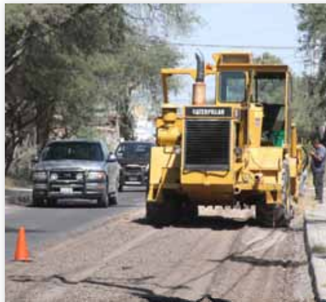
Obras de modernización de pavimentos en Avenida Concepción
