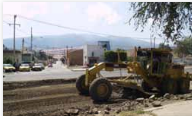
Obras en la carretera San Miguel – San Juan
