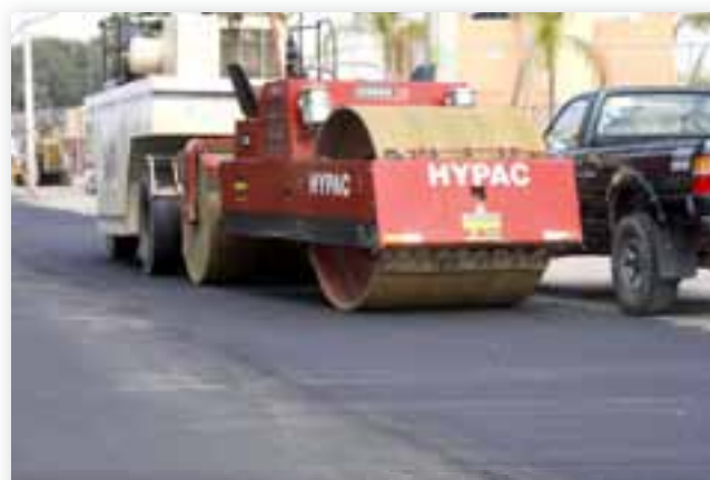
Trabajos de repavimentación
