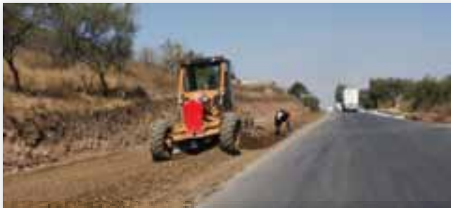
Obras en el Circuito Sur
