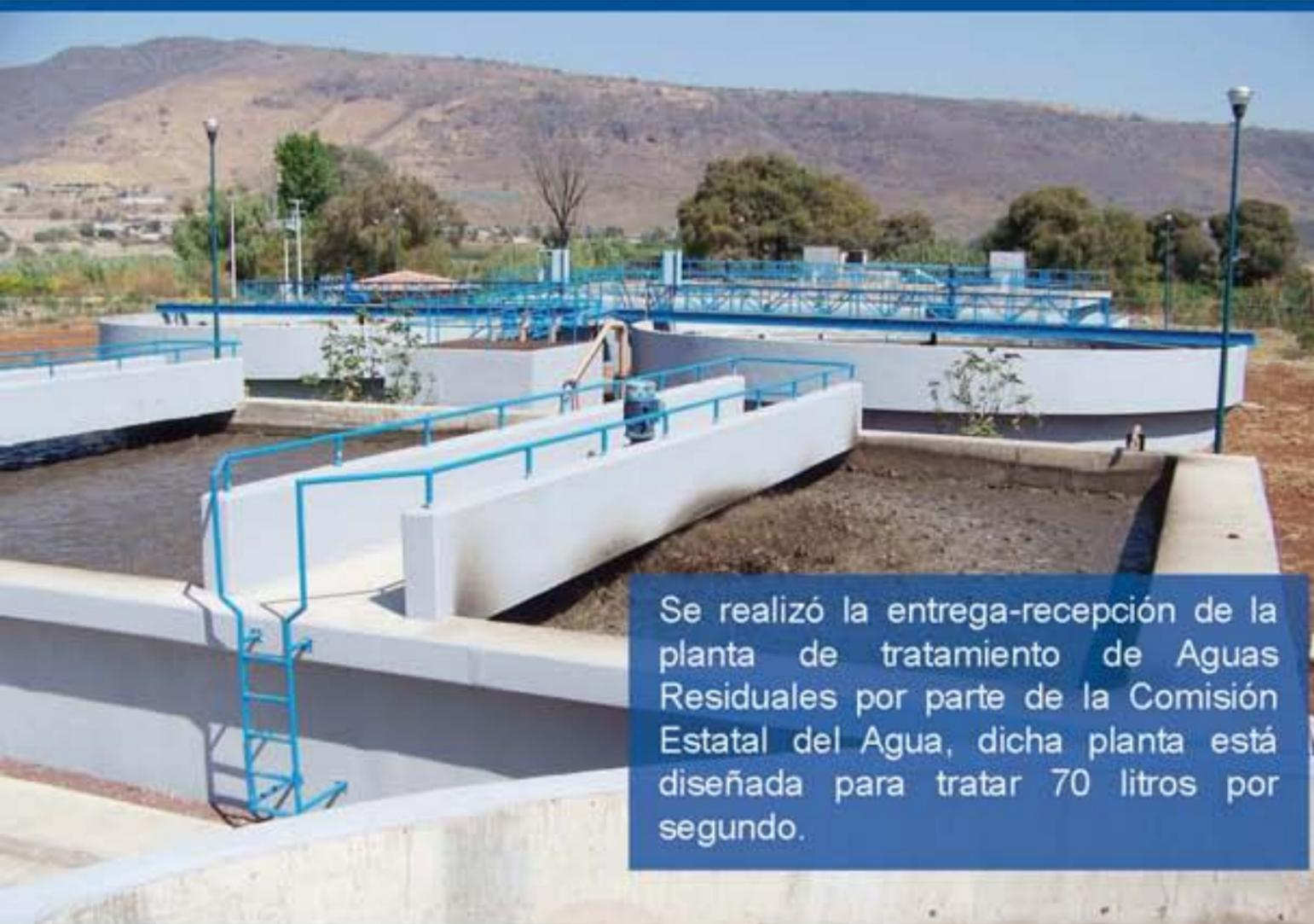
Se realizó la entrega-recepción de la planta de tratamiento de Aguas Residuales por parte de la Comisión Estatal del Agua, dicha planta está diseñada para tratar 70 litros por segundo.
