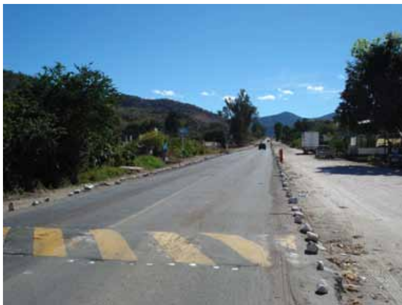
Ampliación de la carretera a San Martín de las Flores
