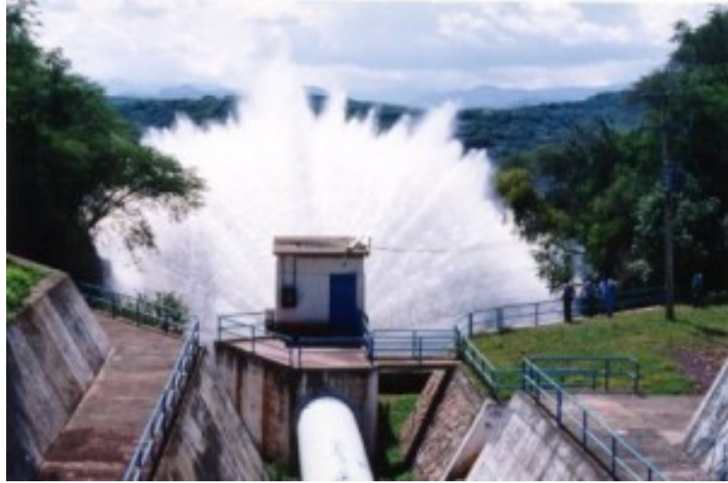
Obra de Toma de Presa Tacotan “La válvula”.
