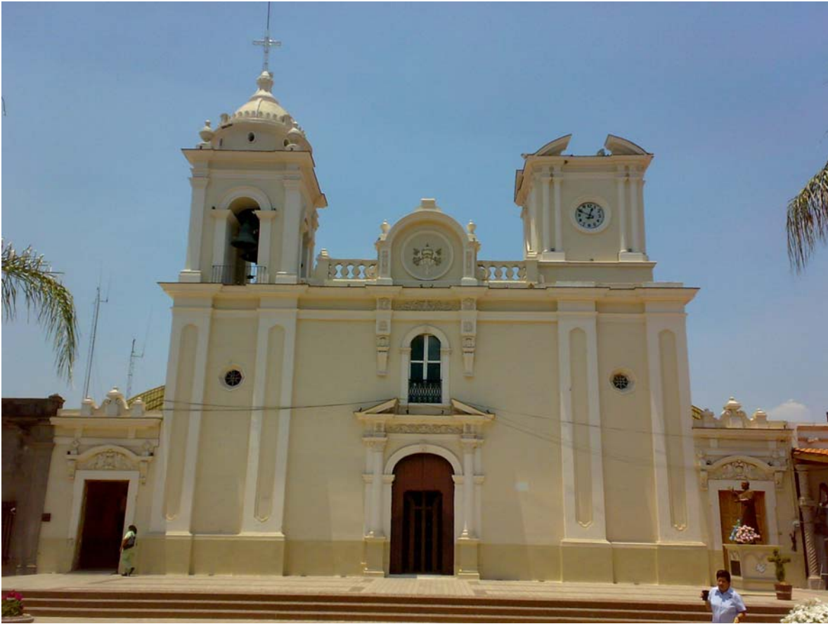
Fachada del Templo Sta. María de Guadalupe
