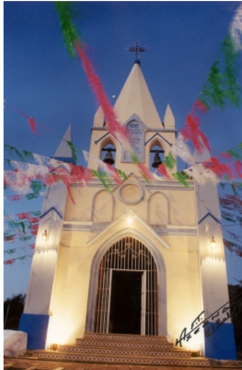
Fachada de la Capilla del Cerrito
